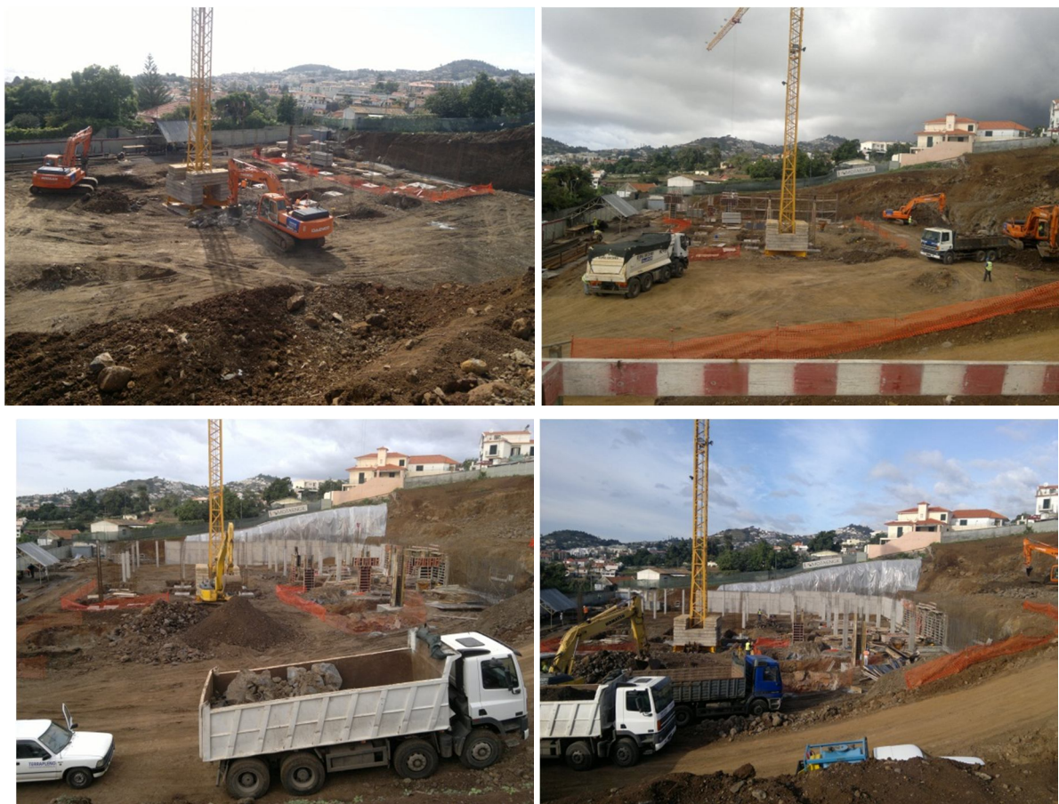
Figura 5.35 – Estrutura de betão armado: pilares, fundações e muros do corpo A (Outubro/Novembro 2011)
