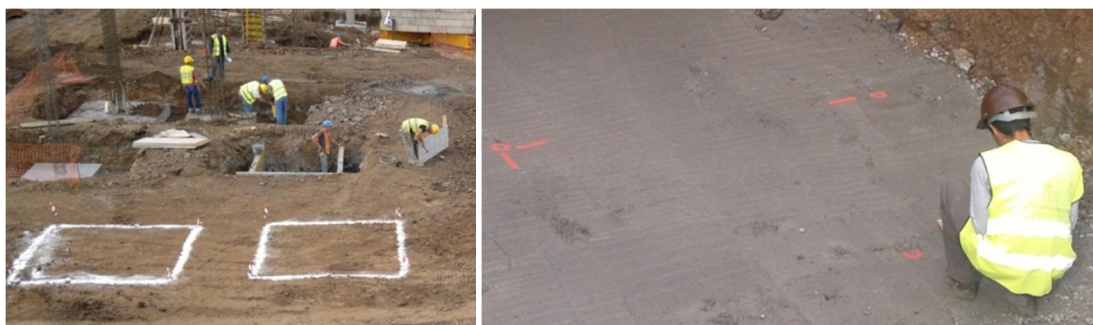
Figura 5.2 – Implantação dos elementos
