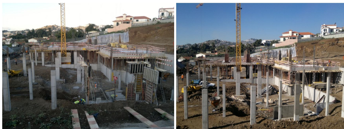
Figura 5.37 – Estrutura de betão armado: pilares, fundações e muros dos corpos A e B (Janeiro 2012)
