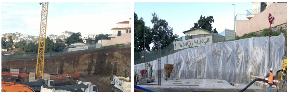
Figura 4.14 – Proteção do talude das águas das chuvas
