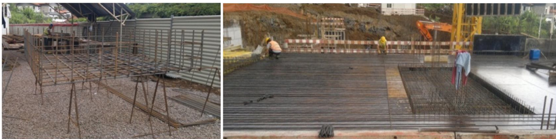
Figura 5.4 – Execução das armaduras (à direita na oficina de armaduras, à esquerda no local)
