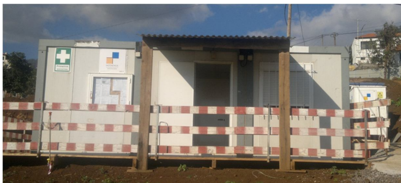
Figura 5.27 – Escritório de obra
