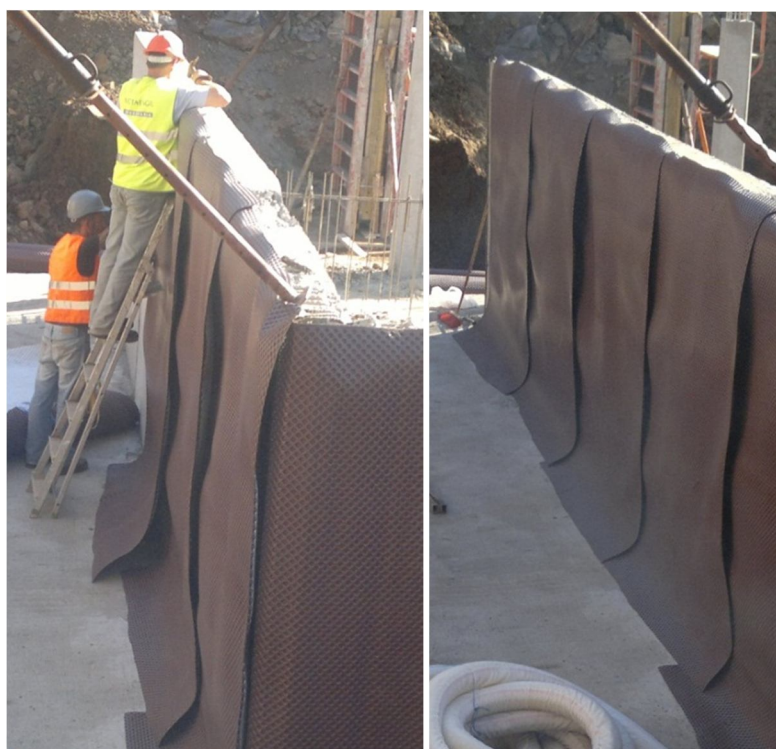
Figura 5.9 – Aplicação da tela drenante
