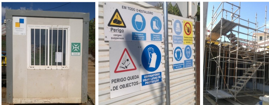
Figura 5.28 – Instalações de apoio – controlo
