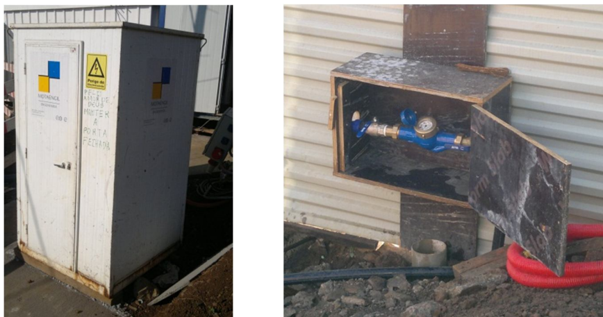
Figura 5.32 – Redes de infraestruturas provisórias
