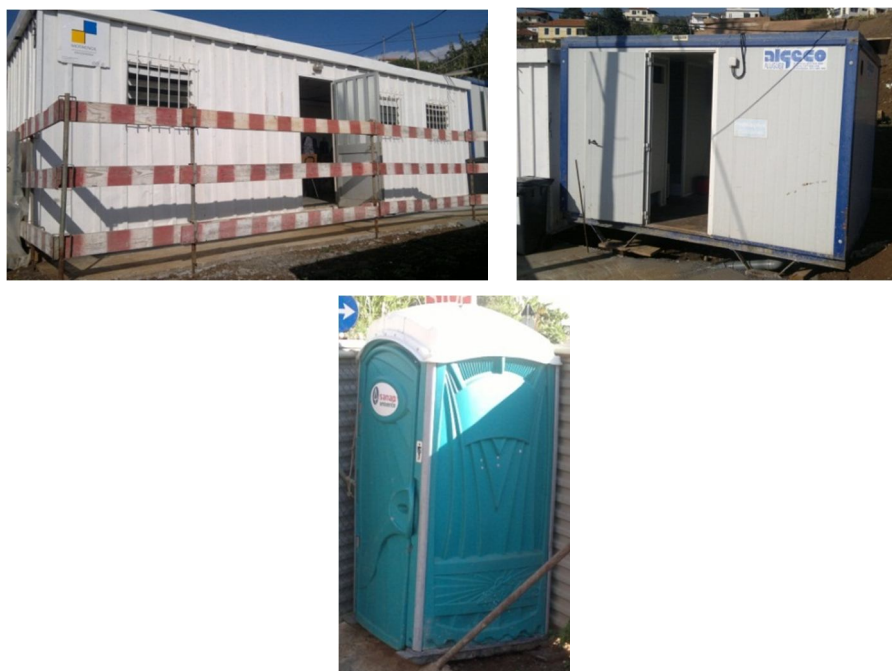
Figura 5.29 – Instalações de apoio – social
