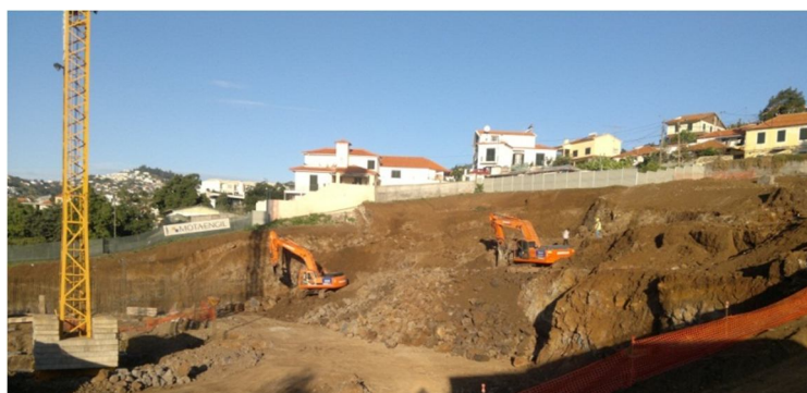
Figura 4.13 – Casas adjacentes à obra
