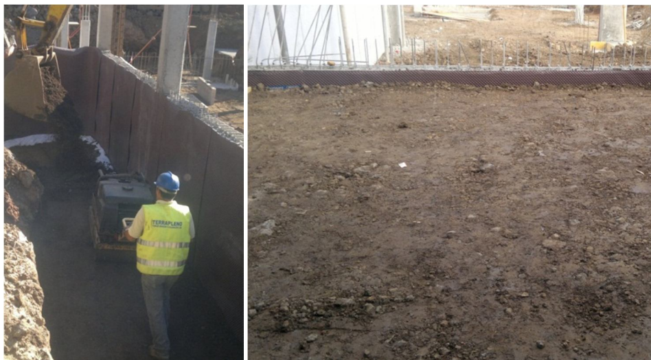
Figura 5.11 – Realização do aterro por camadas
