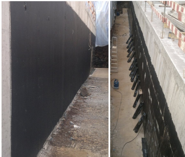
Figura 5.8 – Aplicação da emulsão betuminosa e tela betuminosa
