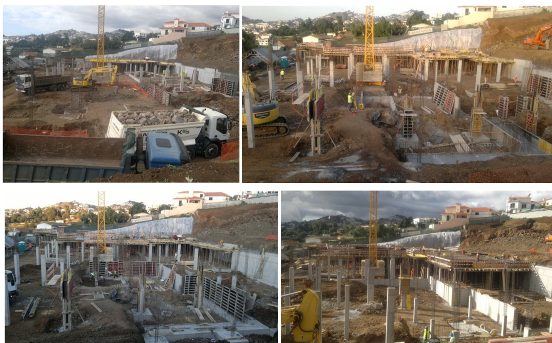
Figura 5.36 – Estrutura de betão armado: pilares, fundações e muros dos corpos A e B; fabrico de lajes do corpo A (Novembro/Dezembro 2011)
