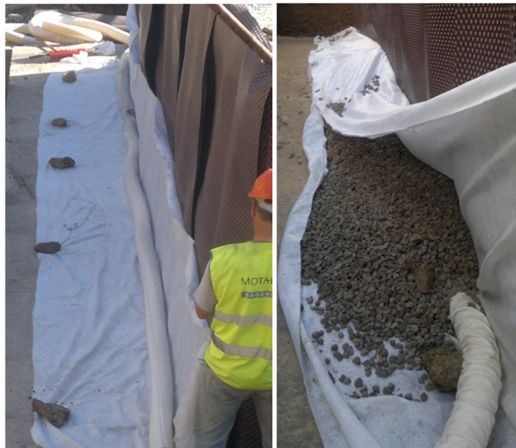
Figura 5.10 – Colocação do tubo geodreno
