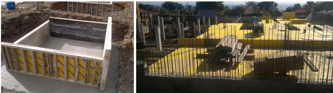
Figura 5.3 – Execução das cofragens
