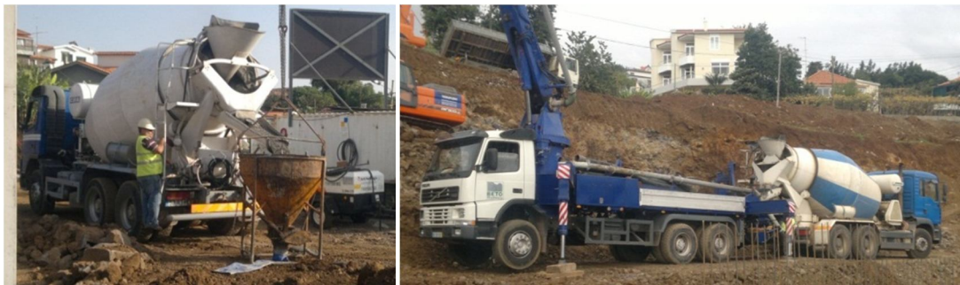
Figura 5.5 – Transporte e colocação do betão (por balde ou por autobomba)
