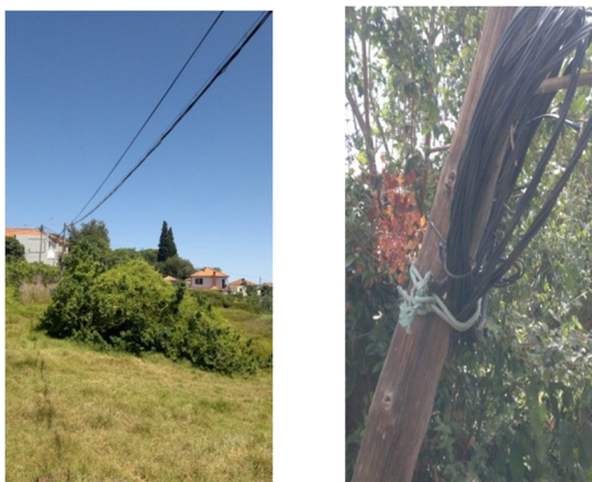
Figura 4.11 – Deslocamento das linhas existentes
