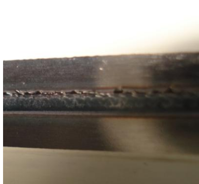
Figura 10 - Cordão conforme rugoso
