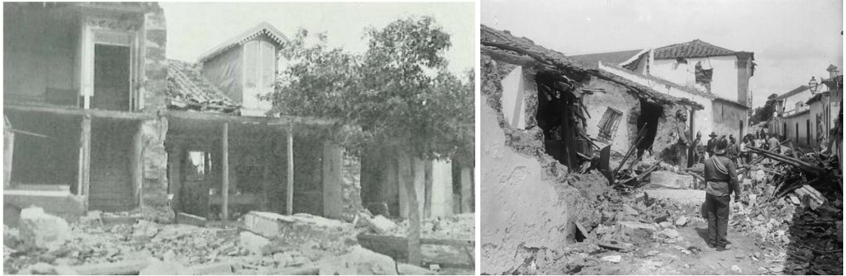
Figura 3.3 – Danos nos edifícios de Benavente (Ilustração Portuguesa, 1909)
