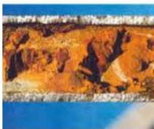
Corrosão pelo interior
