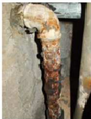
Figura 6.4 – Exemplo de anomalia muito grave em rede de abastecimento de água (MAEC,2007).
