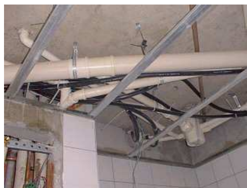
Instalação em tetos falsos
