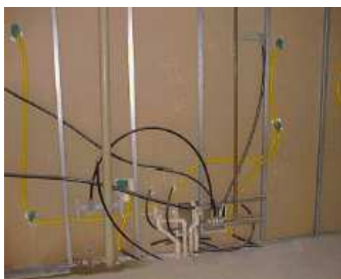
Rede em estrutura metálica entre paredes de gesso cartonado.
