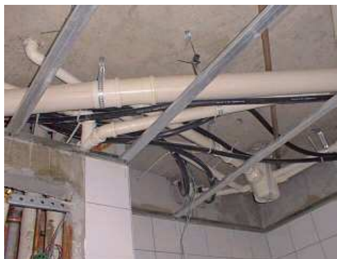
Instalação em tetos falsos.
