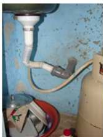
Figura 6.6 – Exemplos de anomalias médias em redes de drenagem de águas residuais domésticas (MAEC,2007).
