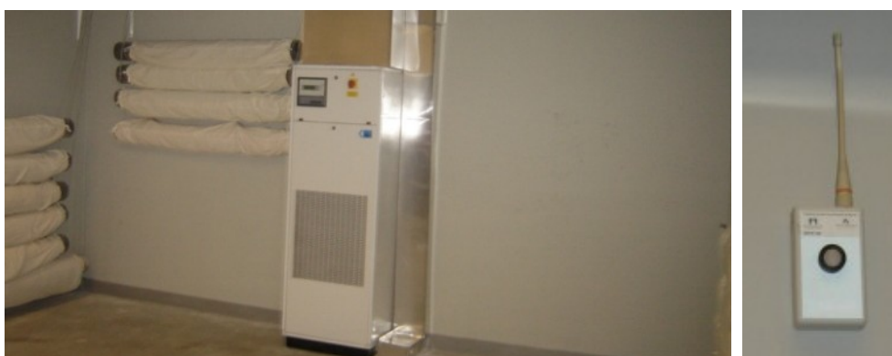
FOTOGRAFIA Nº 1 E Nº2. Sistema de monitorização ambiental e dataloggers . (SOARES. MMP, 2011).
