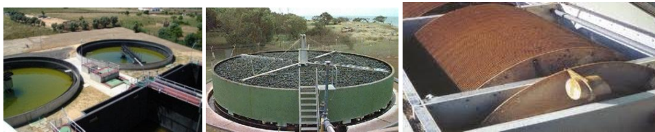
Figura 1.4 – Exemplos de sistemas de tratamento biológico: Lamas activadas; Leitões percoladores e Discos biológicos.
