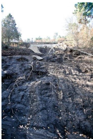
Figura 4.3 - Derrocada sobre a encosta (Janeiro 2012)
