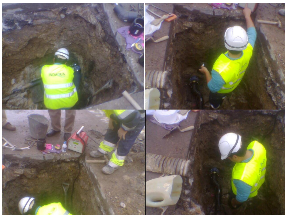
Figura 48: Reparação de uma conduta com abertura de vala e com eletrofusão (soldadura) da conduta.
