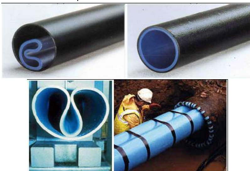
Figura 39: Técnica de re-entubamento com tubo de parede dobrada.
