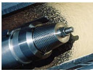
Figura 35: Técnica de Spray Relining (espigão de aplicação de resina).
