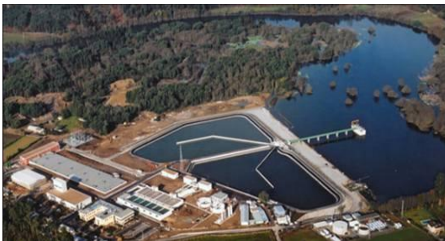
Figura 12: Aspecto das Infra-estruturas de captação e tratamento do Sistema Multimunicipal em Areias de Vilar. Capacidade diária para tratar 146.000m 3 de água [1]
