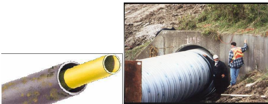
Figura 36: Técnica de re-entubamento simples.
