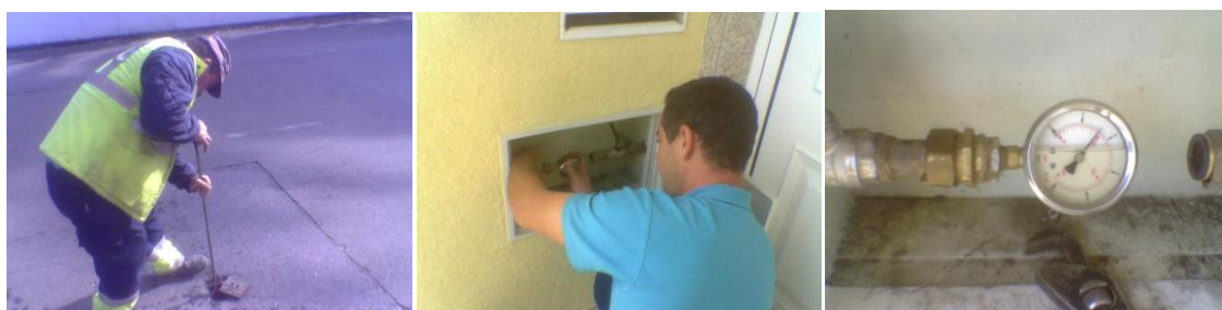
Figura 47: Detecção de fugas em ramal. Fecho de Válvula (Cabeça Móvel); Tirar contador/Colocar Manómetro de Pressão; Leitura da Variação da Pressão durante 5 a 10 min.
