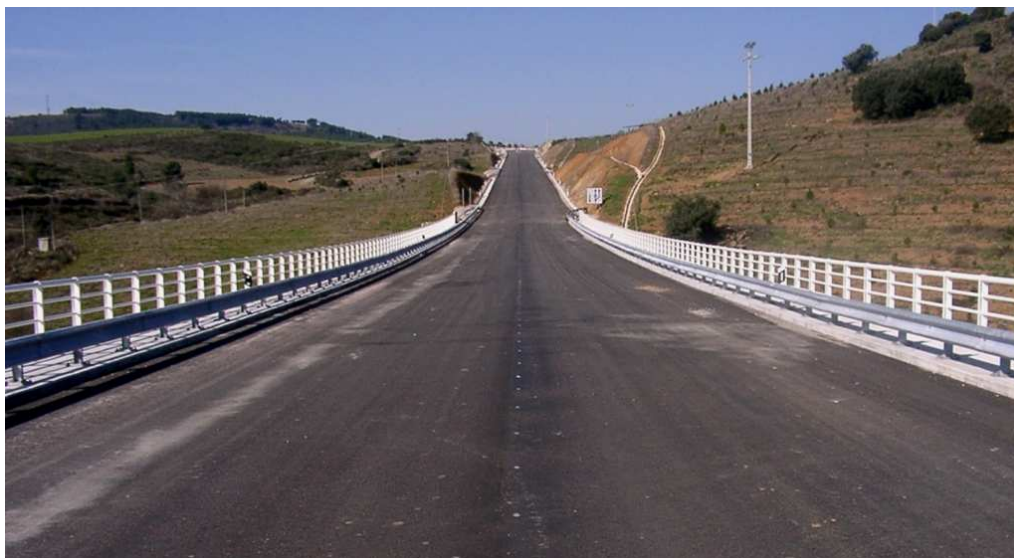
Figura 3 – Troço da Variante à EN 218 entre Vimioso e Caçarelhos (cedida por EP – Estradas de Portugal, S.A.)
