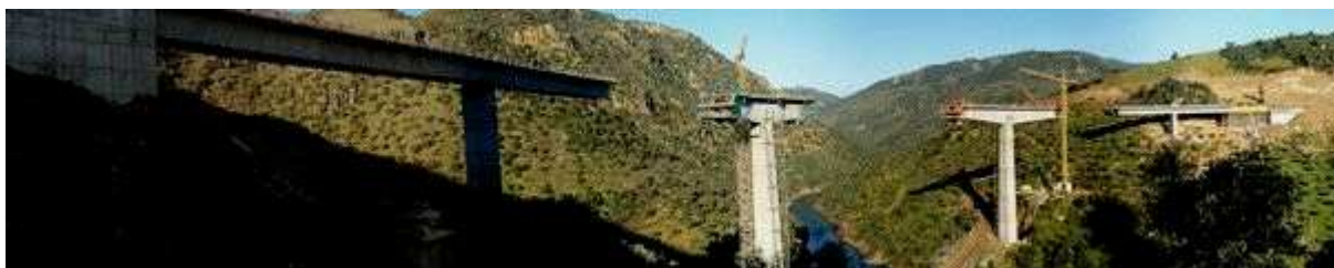
Figura 6 – Ponte sobre o Rio Sabor (cedida por EP – Estradas de Portugal, S.A.)
