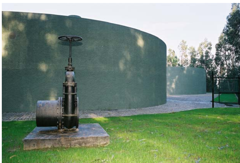
Fig.8.8 - Vista panorâmica do Reservatório de Cerite
