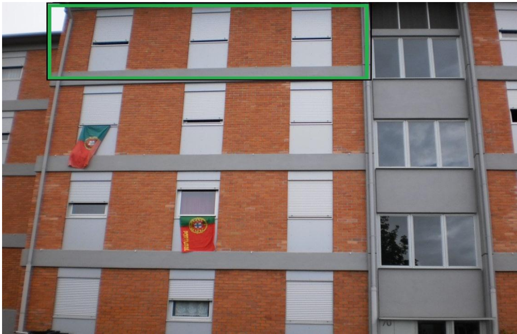
Figura 4 – Fachada Sudoeste do edifício em estudo [14]
