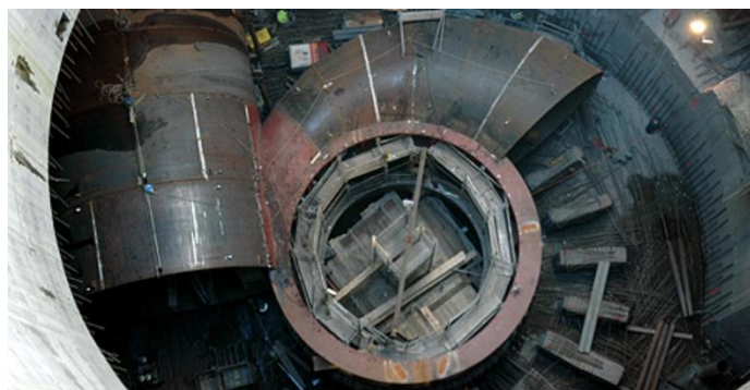
Fig. 7 – Caixa espiral com os primeiros anéis montados [7]
