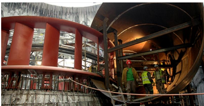
Fig. 8 – Caixa espiral e o anel central com aberturas e lâminas para condução da água [7]
