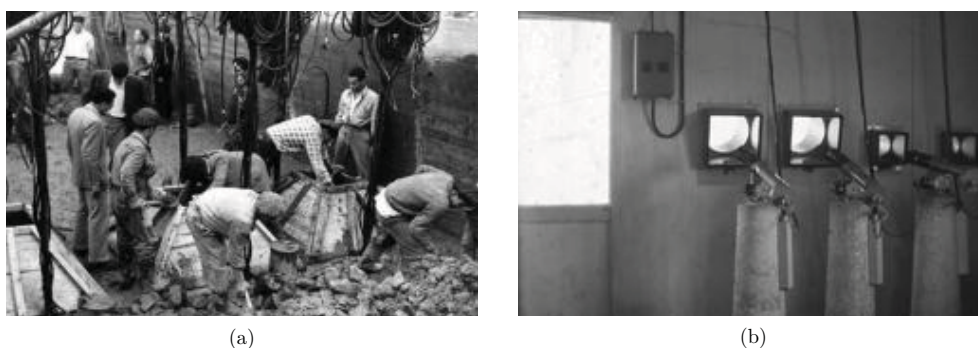
FIGURA 1.6: Instrumentações realizadas pelo LNEC nas décadas de 50 e 60: a) instalação de extensómetros de embeber na Barragem da Bouçã, 1955; b) sistema de medição de deslocamentos por meio de dispositivos ópticos aplicado na Ponte 25 de Abril (LNEC, 2011).
