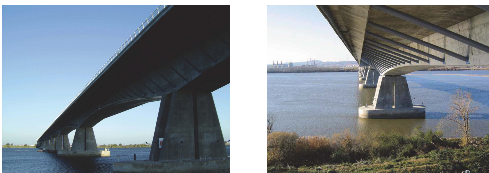
FIGURA 7.7: Vistas gerais da Ponte da Lezíria.
