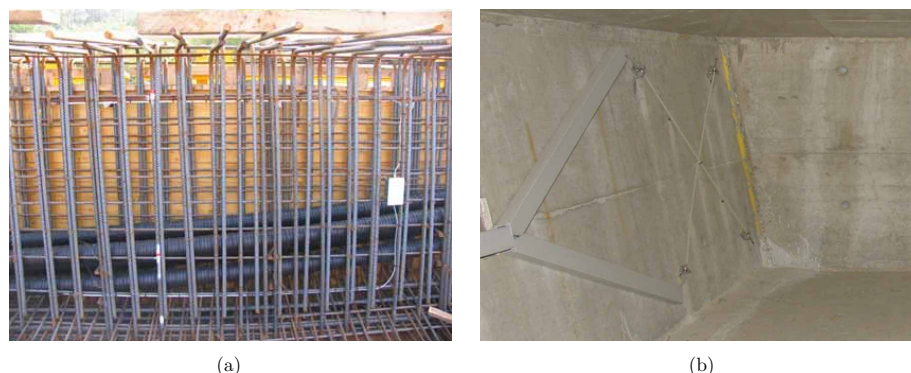
FIGURA 4.34: Instalação dos sensores de deformação na Ponte Ricciolo durante a sua construção: a) sensores paralelos embebidos no betão (secção C); b) cruz de sensores externos junto da secção de apoio (secção E) (Glisic et al., 2008, 2010).
