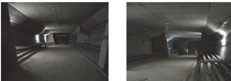
FIGURA 7.8: Vistas interiores do tabuleiro em caixão da Ponte da Lezíria.
