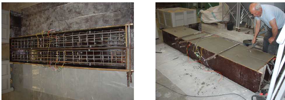
FIGURA 5.29: Betonagem do par de vigas.
