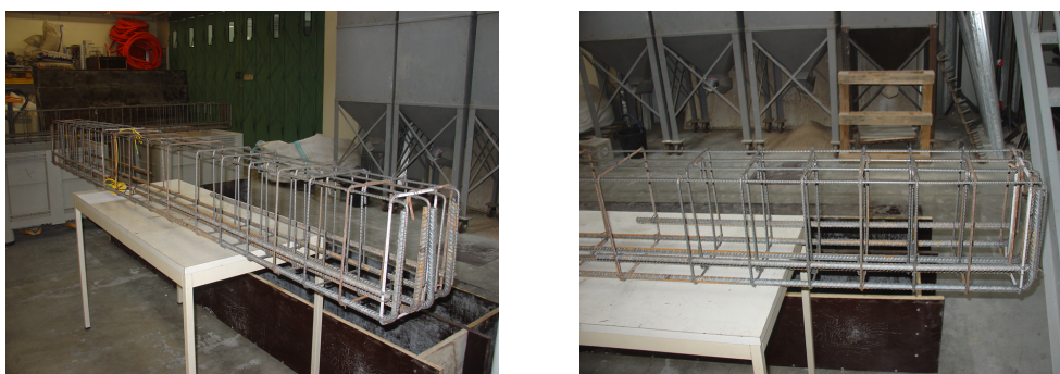
FIGURA 5.27: Vistas gerais da disposição de armadura na viga.
