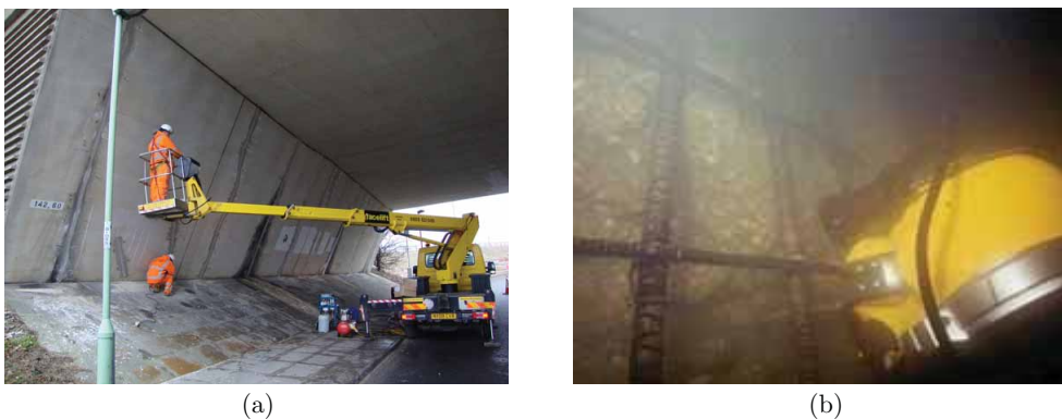
FIGURA 1.3: Inspeções visuais: a) inspeção à superestrutura; b) inspeção subaquática.
