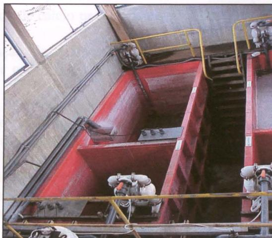
Fig.5 – Tanque de retenção dos efluentes ácidos e dos efluentes ácidos com crómio
