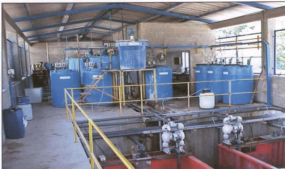
Fig.12 – Bidões que contém os reagentes de auxílio aos tratamentos dos efluentes
