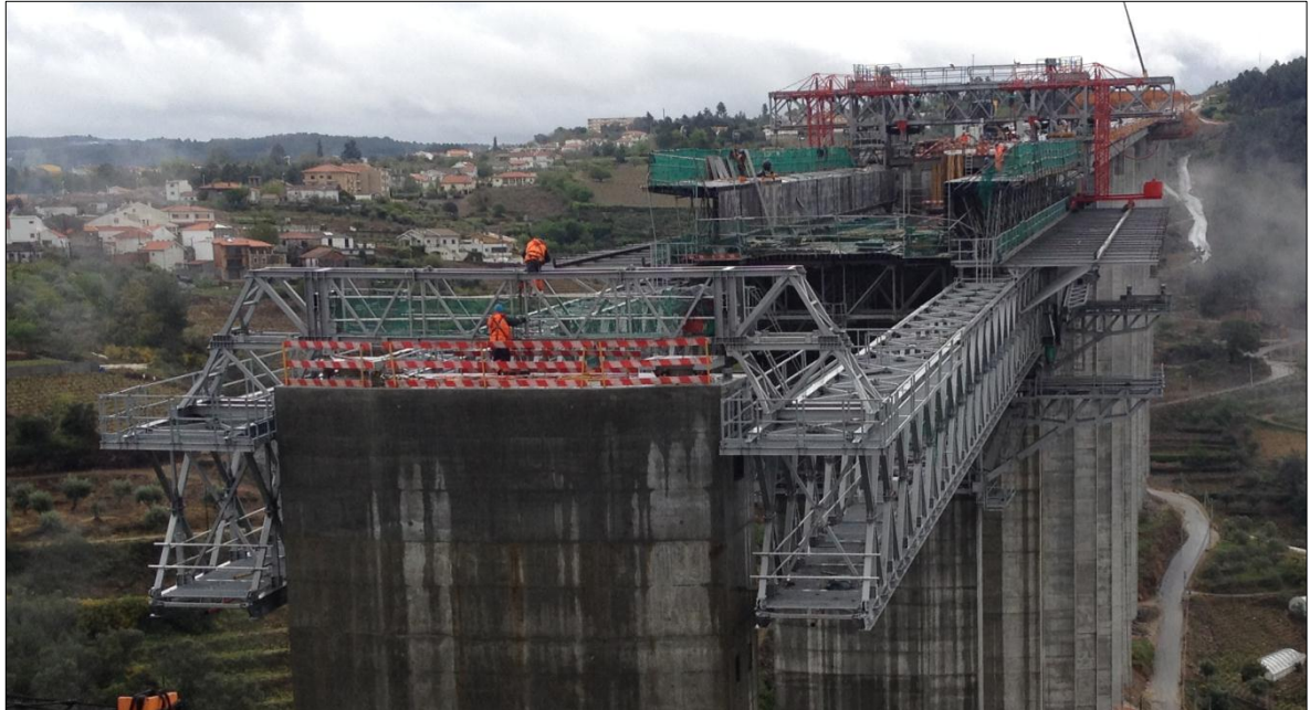
Fig. 3.4.3 – Vigas principais do cimbra M60-I, em Corgo.
