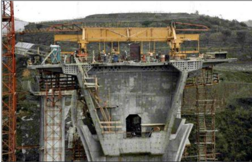
Fig. 2.3.9 – Construção da aduela zero [13].
