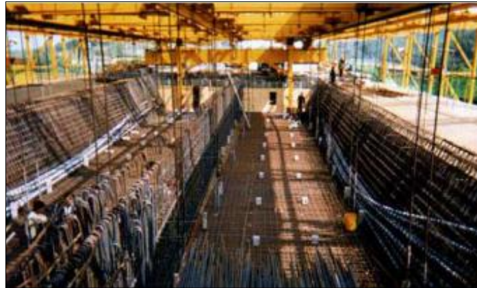
Fig. 2.4.6 – Instalação da armadura [17].
