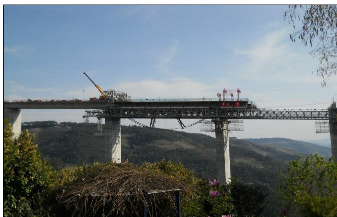
Fig. 4.1.7 – Faseamento construtivo (4/5)L + (1/5)L [23].
