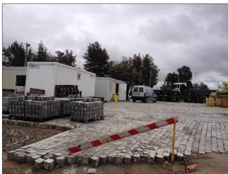
Fig. 4.2.12 – Provetes resultantes de ensaios, em Corgo.
