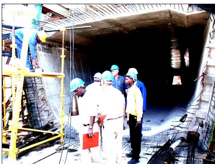
Fig. 2.2.2 – Área de pré-fabricação numa extremidade.
