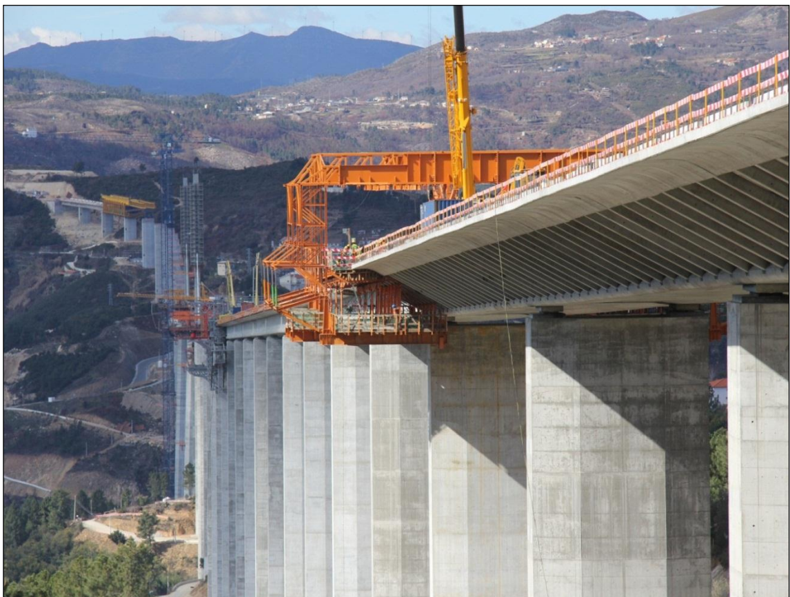
Fig. 4.1.1 – Viaduto do Corgo, vista do lado Nascente.
