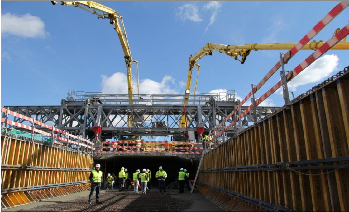
Fig. 4.1.8 – Tabuleiro preparado para receber as duas primeiras fases de betonagem.
