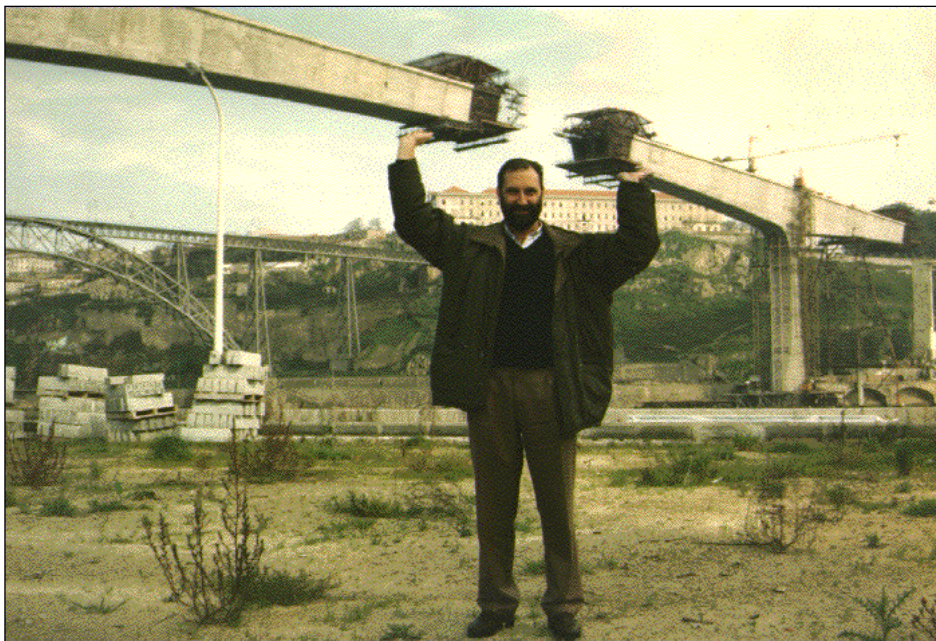
Fig. 2.3.2 – Construção da aduela de fecho ponte S.João, Porto [9].
