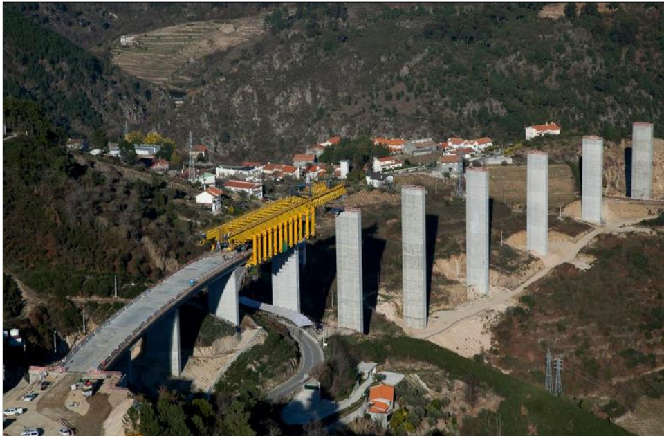
Fig. 2.4.1 – Vista geral de um cimbra autolançável superior, em Viaduto do Corgo [14].
