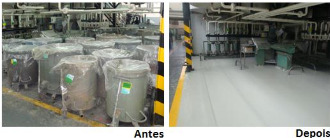
Figura 34 – Reestruturação do espaço dedicado aos produtos intermédios antes e depois da implementação do 1º passo 5S
