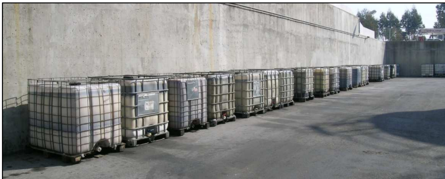
Figura 24. Depósitos de armazenamento dos efluentes.
