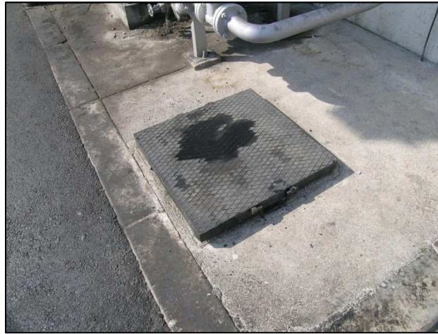
Figura 27. Tanque de homogeneização das escorrências da zona de expedição e da báscula.
