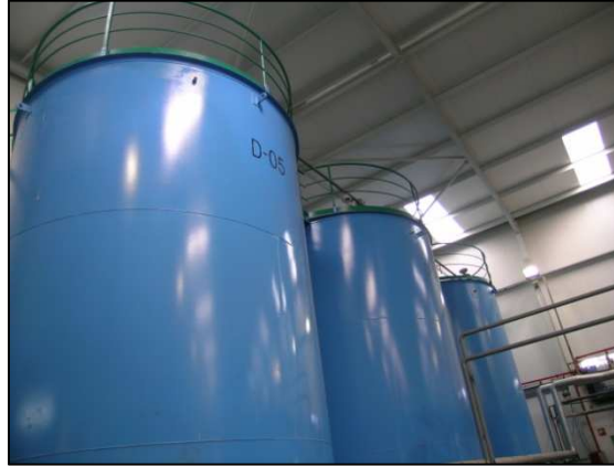
Figura 7. Depósitos D05, D04 e D03.
