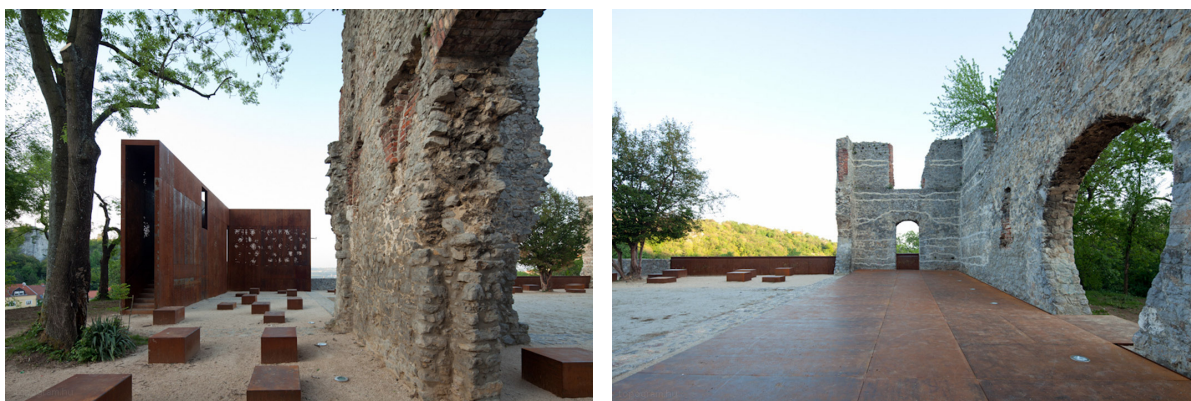
Figura 12. Valorização das ruínas renascentista do Palácio Szathmáry, em Pécs, Hungria, pelo gabinete de arquitetura húngaro MARP. Fotos © Tamás Török. Fonte: Marp.hu.
