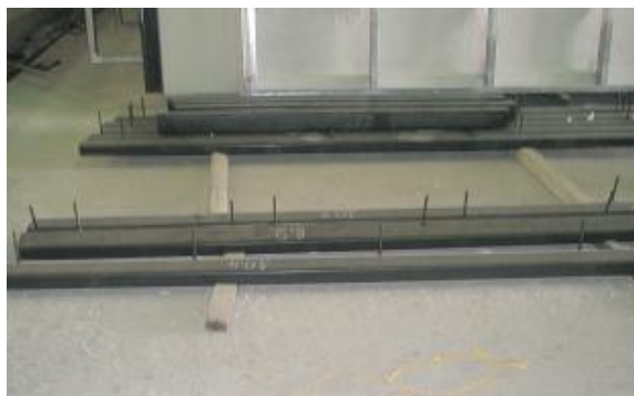
Fig. 5.8 – Perfis UPE 100, integrantes da face dos painéis.
