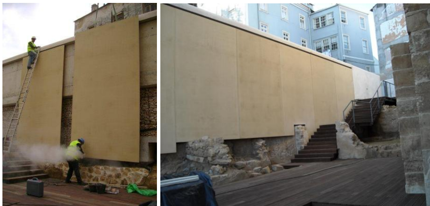
Fig. 3.11 – Recuperação do Mosteiro de Santa Clara, Coimbra, 2008 [17].
