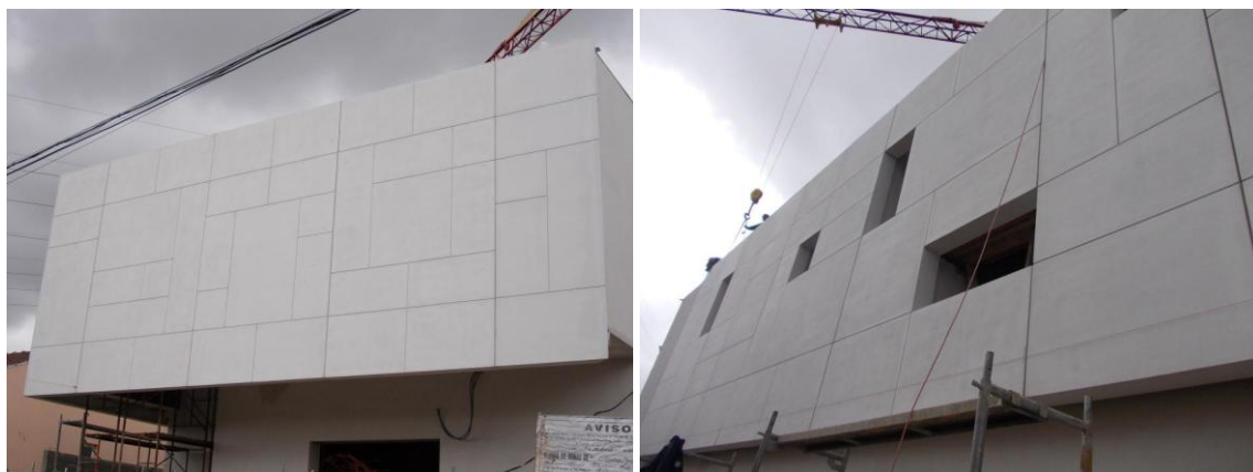
Fig. 3.13 – Fachadas da moradia em Valongo, 2012 [17].
