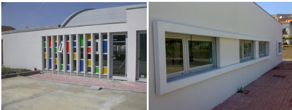
Fig. 3.31 – Creche, Vila do Conde, 2010 [17].
