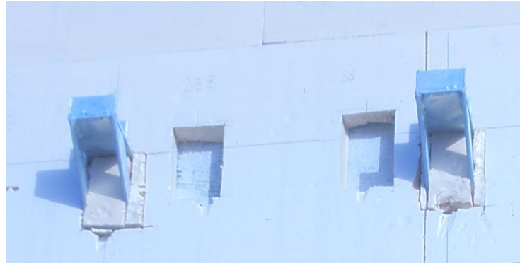
Fig. 5.23 – Cantoneiras tipo 1 (fixações inferiores) aplicadas na fachada.
