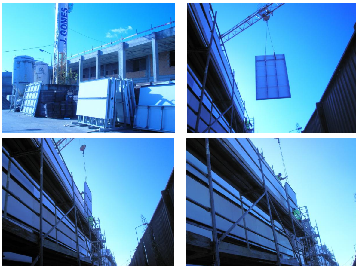
Fig. 5.30 – Sequência de montagem de um painel.
