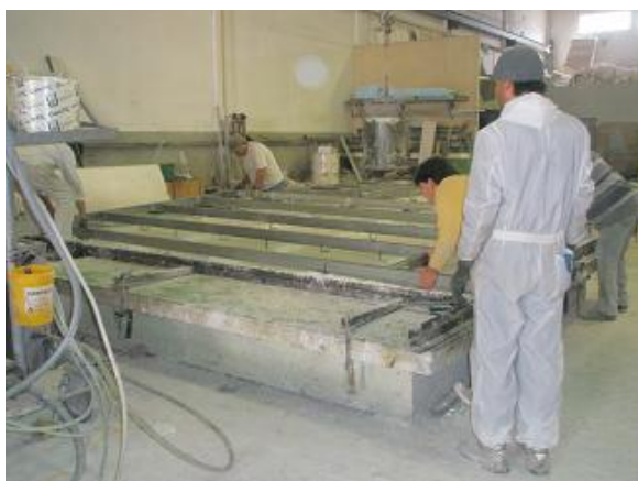
a) Colocação da estrutura metálica stud-frame
