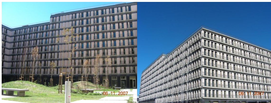
Fig. 3.2 – Empreendimento de habitação da EPUL, Lisboa [17].
