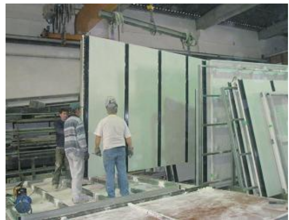
d) Colocação do painel nos cavaletes
