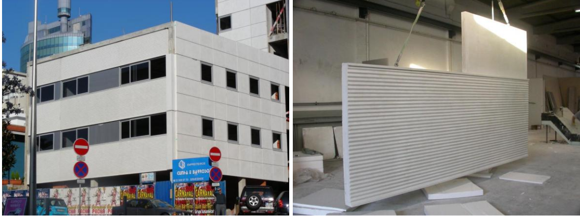
Fig. 3.27 – Edifício de habitação, Maia, 2007 (à direita, exemplo da produção de um dos painéis aplicados na obra) [17].
