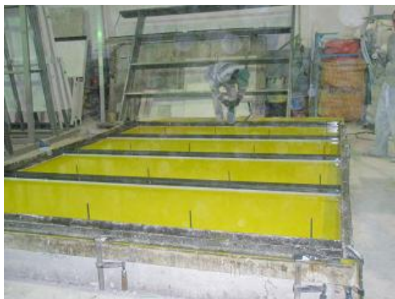
Fig. 5.11 – Após aplicação do descofrante. De notar que a cor amarela deve-se apenas ao facto de se tratar de outra mesa.
