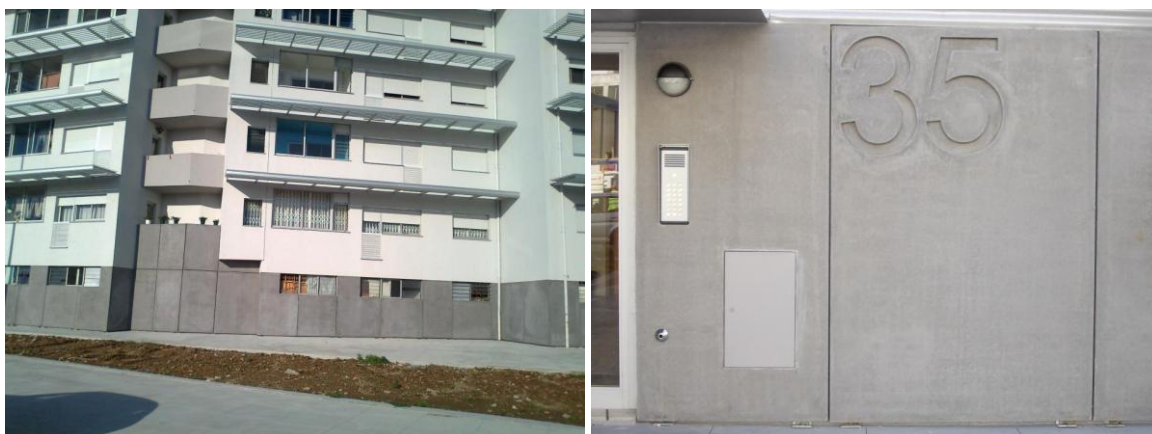
Fig. 3.7 – Reabilitação das fachadas dos edifícios da urbanização de Vila d’Este, Vila Nova de Gaia [17].
