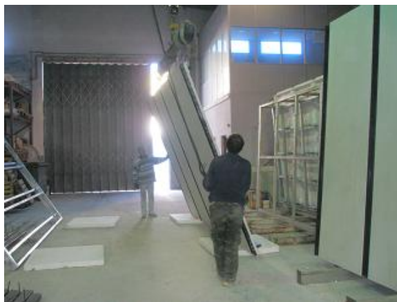
c) Deslocação do painel para colocação nos cavaletes
