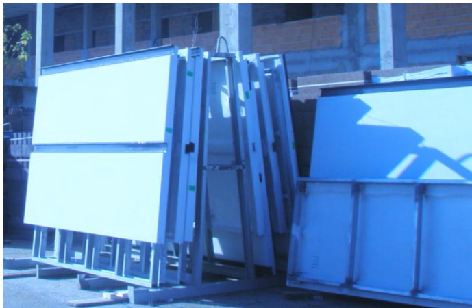
Fig. 5.31 – Pormenor de alguns painéis em que se pode observar a saliência ou reentrância do stud-frame .
