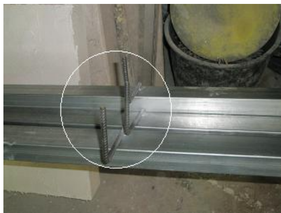
Fig. 5.15 – Pormenor da ancoragem do stud-frame .
