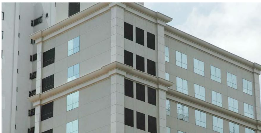
Fig. 3.47 – Edifício de escritórios, Rua de Rocio, São Paulo, Brasil [16].
