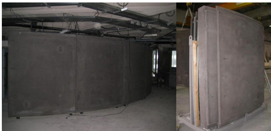
Fig. 3.40 – Painéis stud-frame aplicados na obra do Campus Universitário de Jussieu, Paris, França [17].
