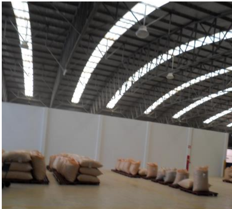
Figura 12 - Setor da receção e armazenamento das rolhas compradas.
