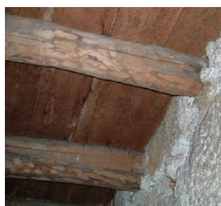
Figura 3.7 – Vigamento com paus rolados falqueados apenas na face superior. Edifício da rua António Carneiro, Porto (Costa, et al., 2007)
