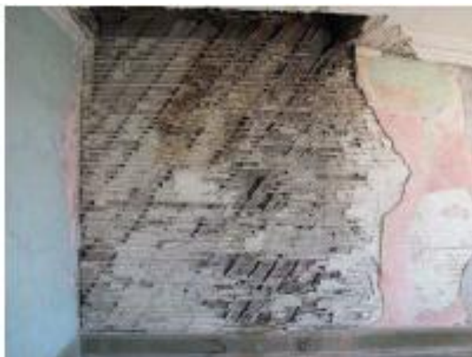
Figura 5.7 - Parede de empena de tabique no piso 3
