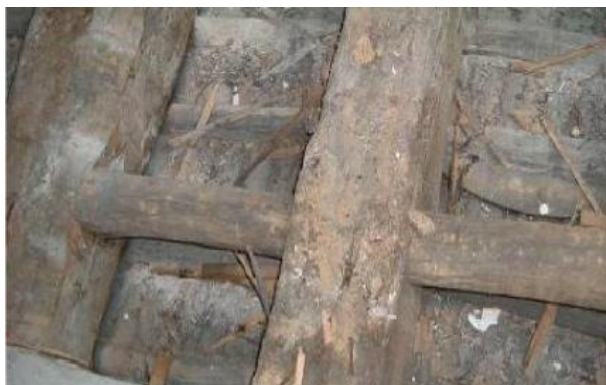
Figura 3.17- Tarugos com secção circular (Ilharco, et al., 2006)
