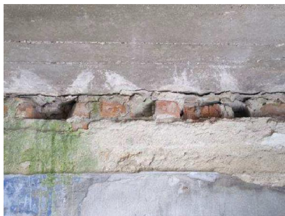
Figura 5.33 – Topo da parede 2 no piso 2 (zona de apoio da laje do piso 3)
