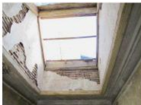
Figura 5.14 - Claraboia da zona da caixa de escadas
