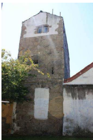
Figura 5.40 – Parede 4, fachada posterior: visão geral
