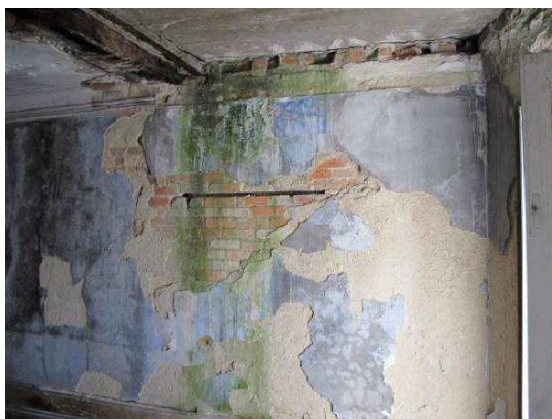
Figura 5.32 – Parede 2, aspeto geral no piso 2
