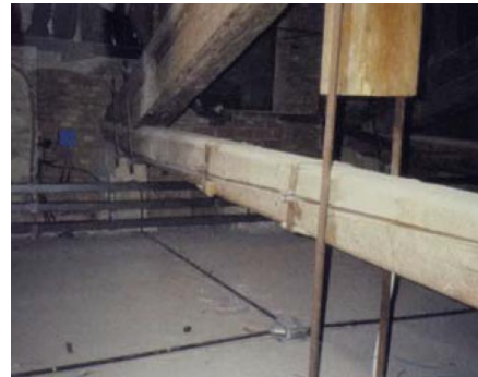
Figura 3.40 - Linha com fenda de secagem extensa e que indica a direção inclinada do fio (Feio, et al., 2005)
