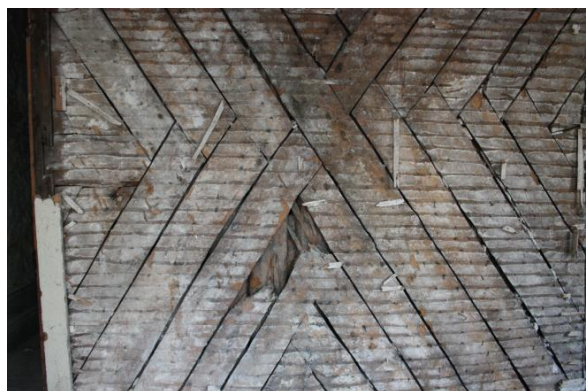
Figura 3.2 - Parede de tabique (NCREP)
