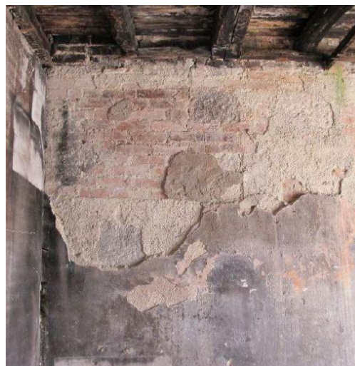
Figura 5.28 – Parede 2, zona de transição para alvenaria de tijolo
