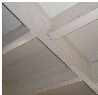
Figura 3.18 - Tarugos com secção retangular (Ilharco, et al., 2006)
