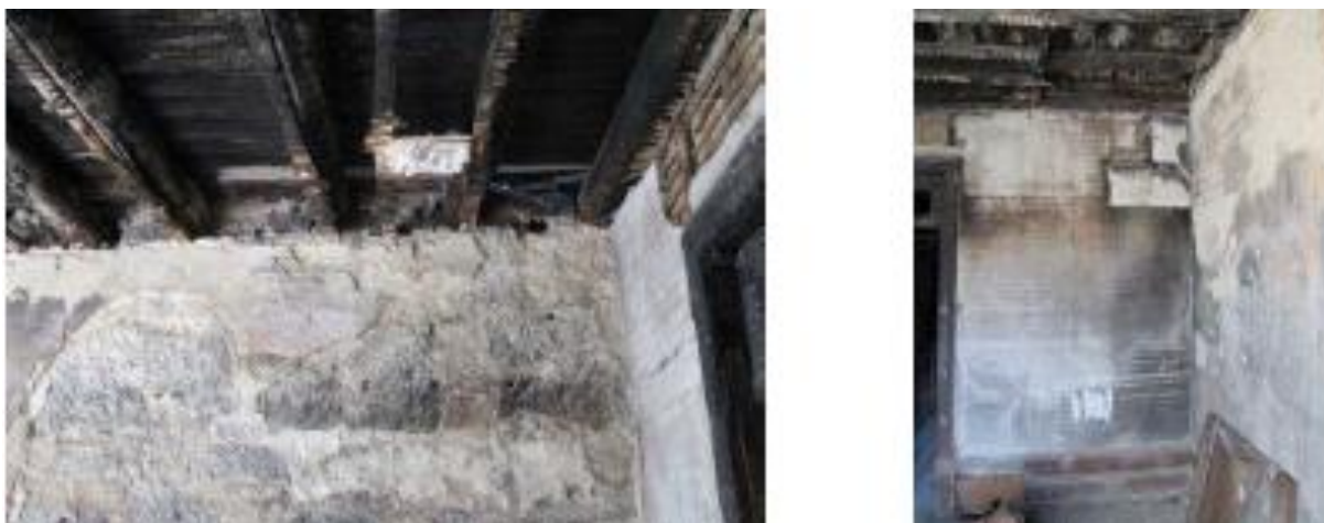
Figura 5.15 - Vestígios de incêndio observáveis nas paredes e nas vigas de madeira
