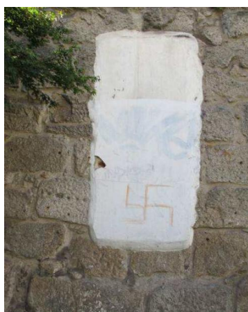
Figura 5.42 – Parede 4, piso 1: sondagem efetuada na zona de antiga abertura - exterior
