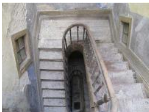
Figura 5.12 - Escada de comunicação entre os pisos -1 e 0
