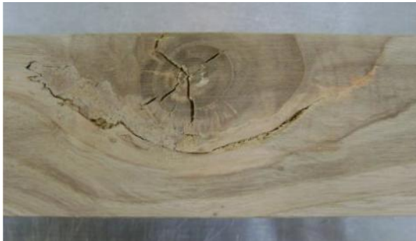
Figura 3.39 - Nó em viga de madeira (Pereira, 2009)
