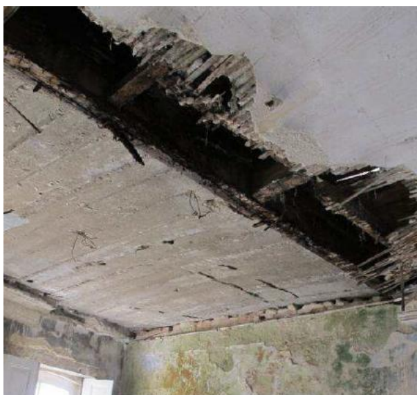
Figura 5.47 – Zona do pavimento do piso 3 em betão armado com perfis metálicos embebidos
