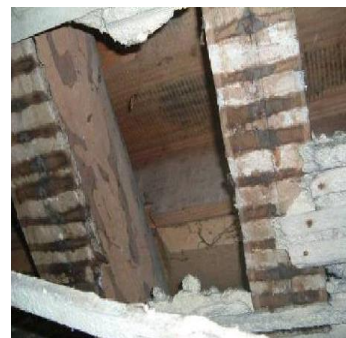
Figura 3.31 - Pernas com secção retangular (Ilharco, 2008)
