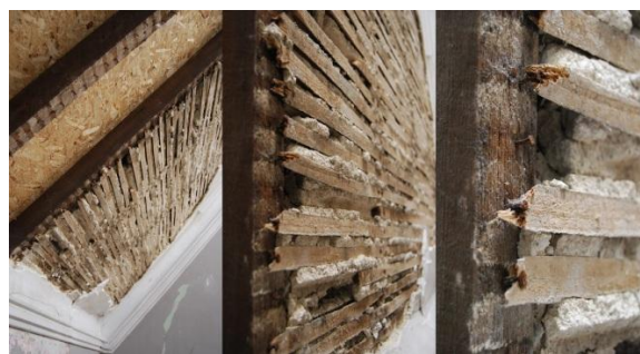
Figura 3.38 - Fasquio com enchimento ([2])
