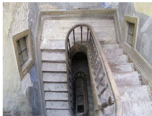
Figura 5.52 – Caixa de escadas dos pisos superiores (vista do piso 3)
