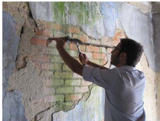
Figura 5.19 - Abertura de janela de sondagem na zona de ancoragem de tirante metálico
