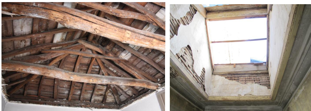
Figura 3.6 - Estrutura da cobertura e claraboia que interrompe o espaçamento das asnas (Fonte: NCREP)
