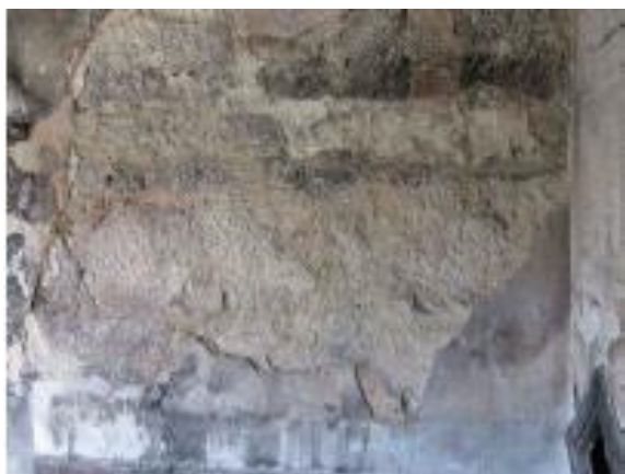
Figura 5.5 – Parede de empena em alvenaria de granito no piso 1
