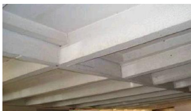
Figura 3.10 - Vigas esquadriadas. Edifício do Largo de S. Domingos, Porto (Ilharco, et al., 2006)
