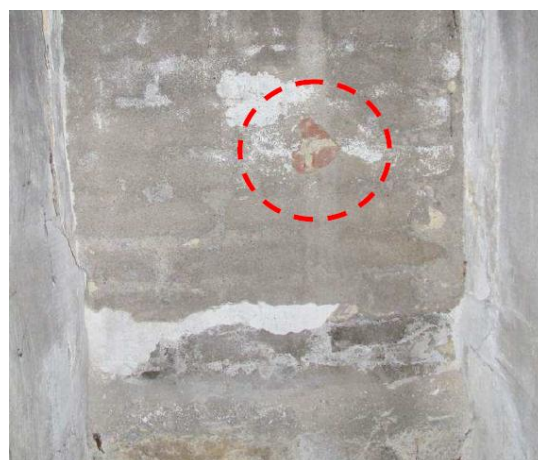
Figura 5.43 – Parede, piso 1: sondagem efetuada na zona de antiga cobertura - interior
