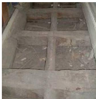
Figura 3.29 - Patamar de piso das escadas (Ilharco, 2008)
