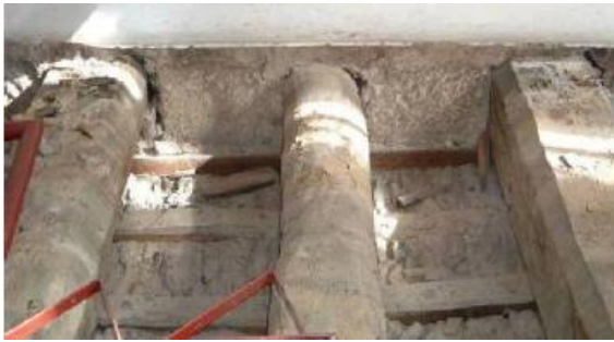
Figura 3.12 – Entrega de vigas com topo alternado encastradas em paredes de alvenaria (Ilharco, et al., 2006)
