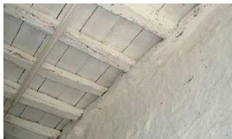
Figura 3.16 – Vigas apoiadas em frechal. Palácio Belomonte, Porto, (Costa, et al., 2007)
