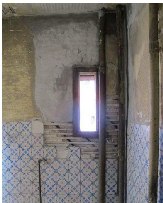
Figura 5.39 - Parede 3, piso 3: tabique
