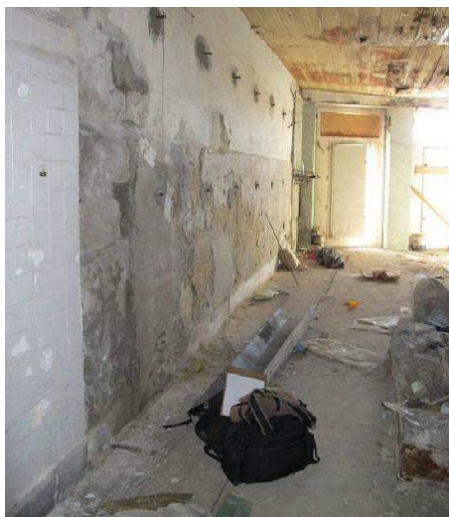
Figura 5.27 – Parede 2 em alvenaria de pedra, Piso 0
