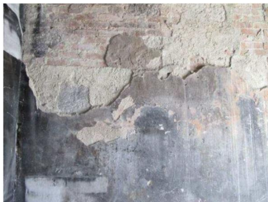
Figura 5.18 - Sondagem na zona de transição entre alvenaria de pedra e tijolo
