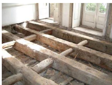
Figura 3.8 – Vigamento em troncos falqueados nas quatro faces. Edifício do Largo de São Domingos, Porto (Ilharco, 2008)
