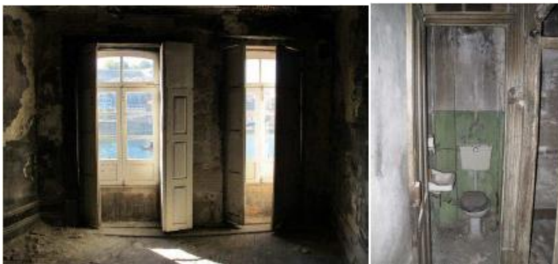
Figura 5.10 – Compartimento na fachada principal e instalação sanitária na fachada posterior (piso 1)
