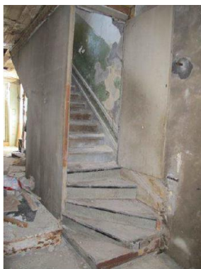
Figura 5.51 – Caixa de escadas entre piso 0 e piso 1
