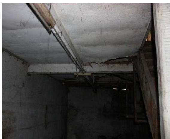
Figura 5.45 – Piso -1: perfis metálicos de suporte do pavimento de madeira do piso 0 e da caixa de escadas
