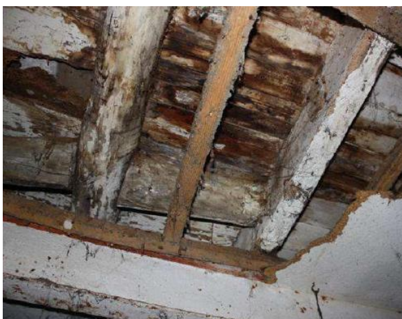
Figura 5.44 – Pavimento do piso 0
