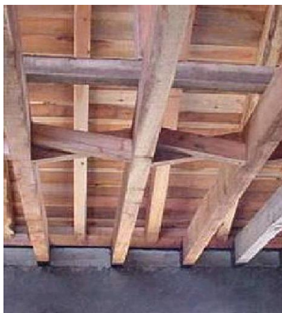
Figura 3.19 - Tarugos de cruzeta executados com ripas de madeira (Ilharco, 2008)
