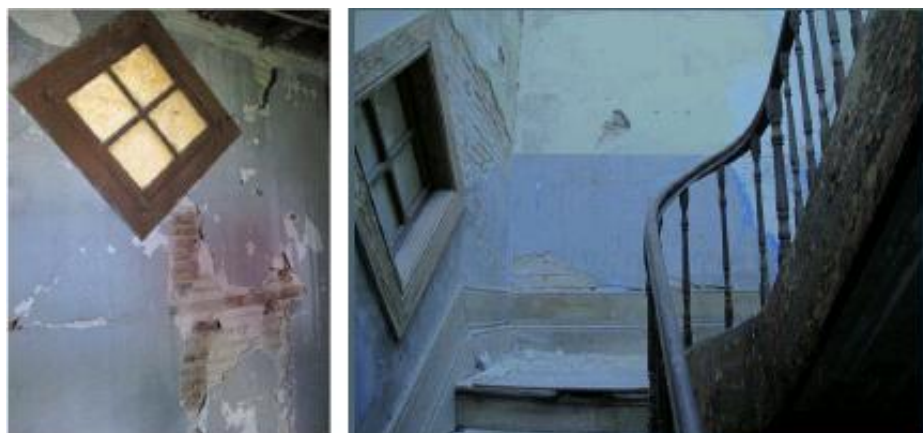
Figura 5.11 - Janela na divisão interior vista do compartimento e da caixa de escadas
