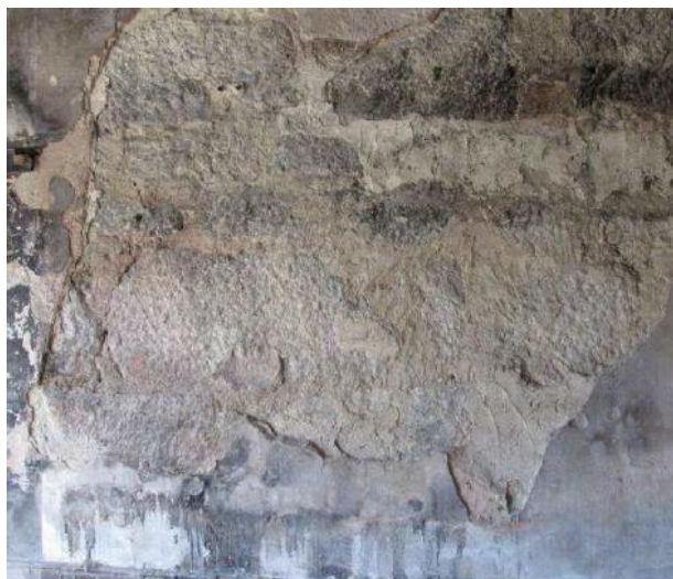
Figura 5.37 – Parede 3, piso 1: alvenaria de granito
