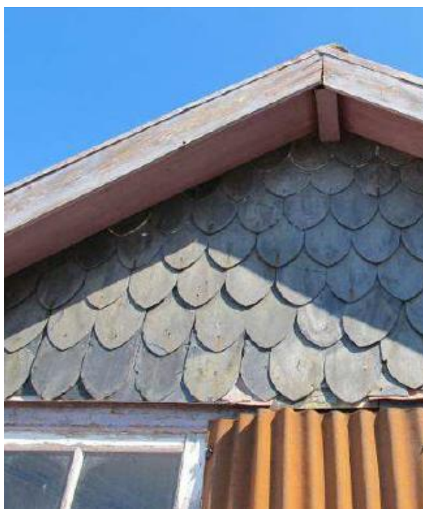
Figura 5.25 – Vista exterior da Parede 1
