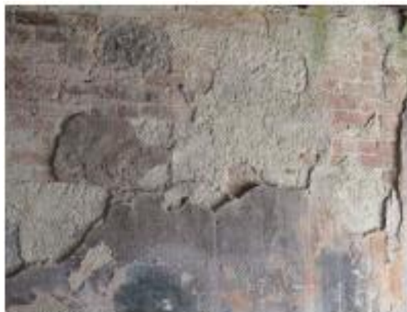
Figura 5.6 – Transição de alvenaria de pedra para alvenaria de tijolo
