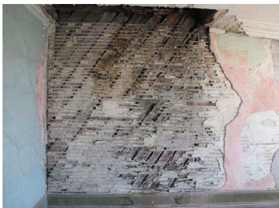
Figura 5.29 - Parede 2, piso 3 em tabique duplo
