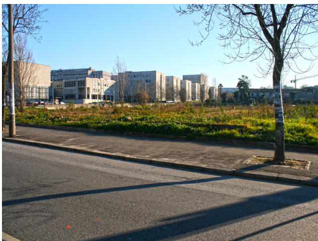
Vias de circulação automóvel
