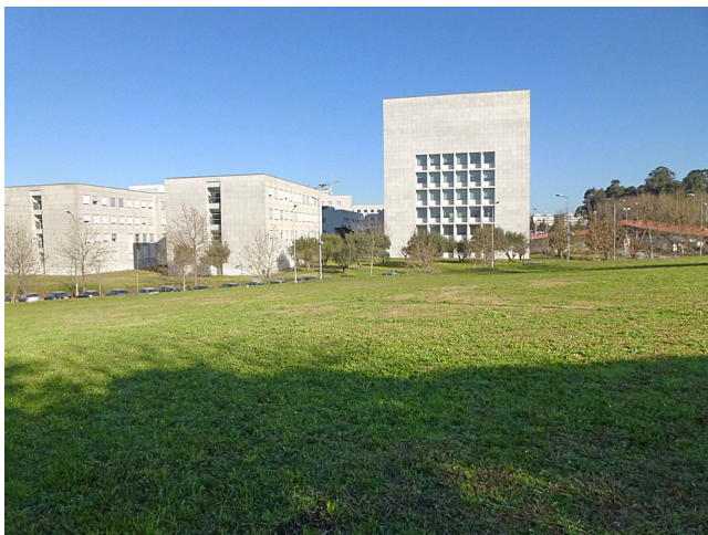
Edifício Faculdade de Engenharia da UP
