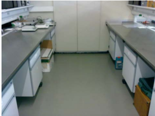
Fig.7.16. – Revestimento de epóxi no laboratório de Física das Construções do edifício G
