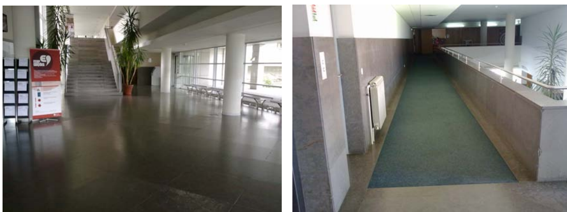
Fig.7.1. – Pedra natural e passadeiras no edifício A
