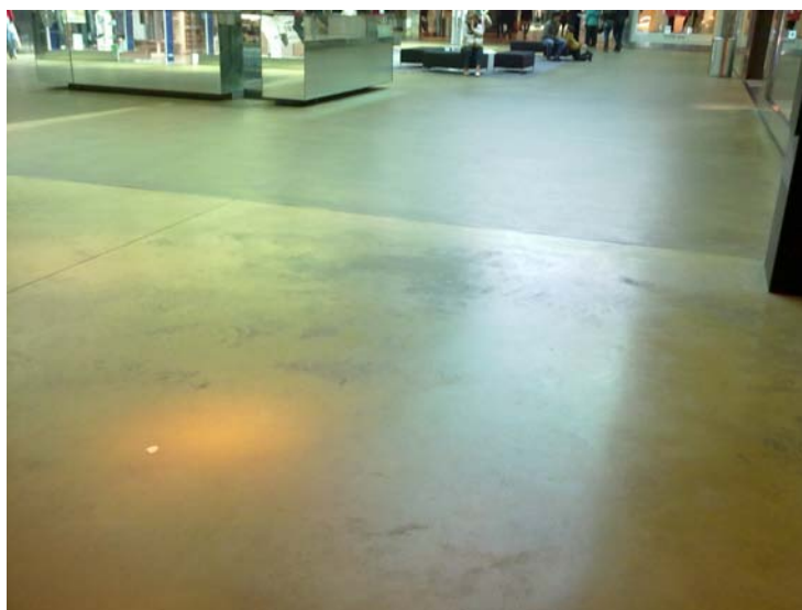
Fig.4.14. – Aplicação de argamassa autonivelante
