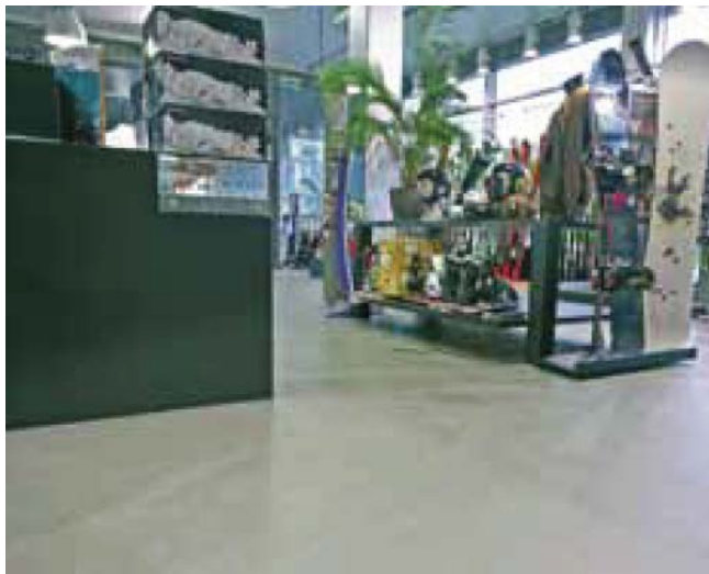
Fig.4.60. – Revestimento em resina de epóxi aplicado em edifício comercial [63]
