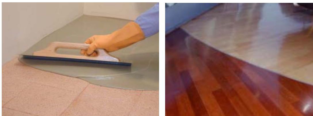
Fig.4.15. – Regularização do suporte de aplicação para aplicação de novo revestimento [37]
