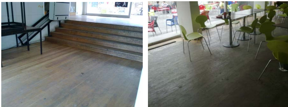
Fig.7.23. – Madeira nas zonas de circulação e de lazer da associação de estudantes do edifício X
