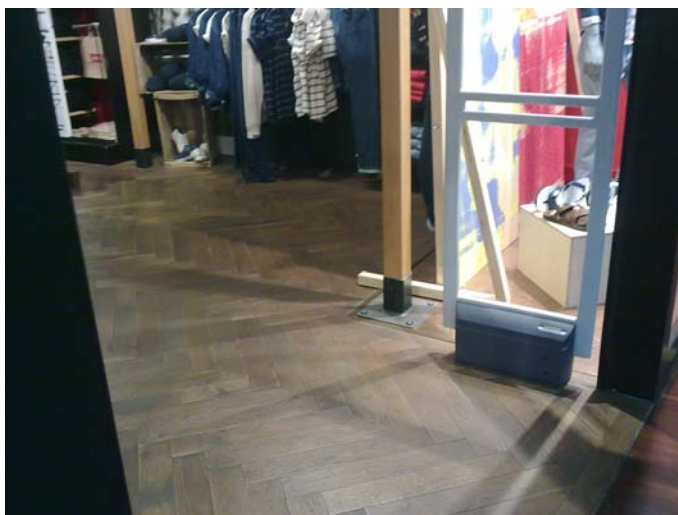
Fig.4.28. – Aplicação de parquete flutuante
