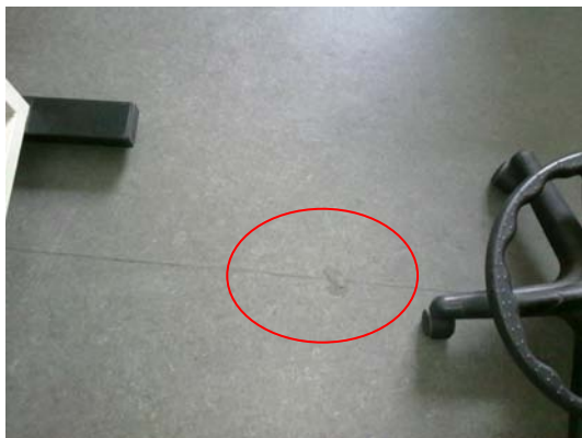
Degradação das juntas
