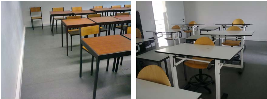
Fig.7.7. – Linóleo em salas de aula no edifício B
