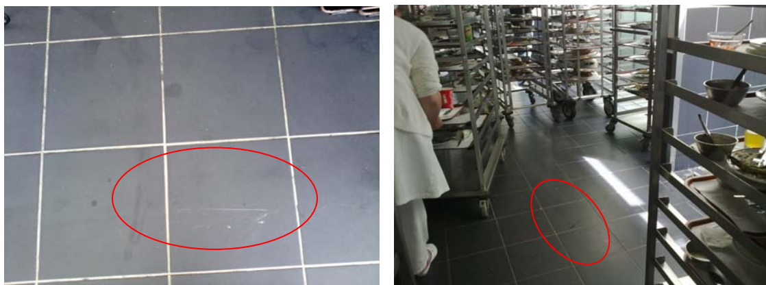
Fig.4.10. – Riscagem da superfície e exposição a gorduras
