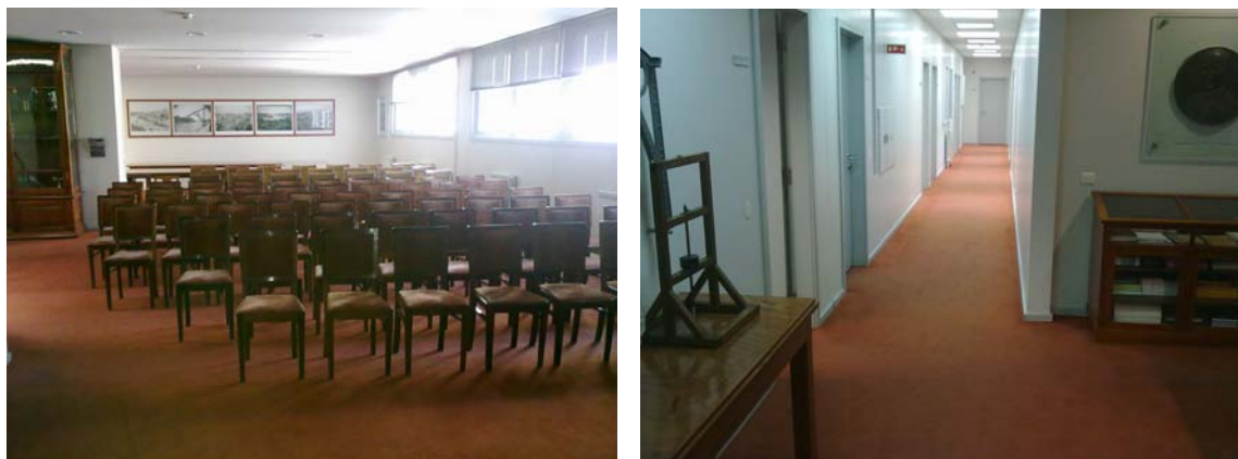
Fig.7.18. – Alcatifa nas zonas de permanência e de circulação do edifício G
