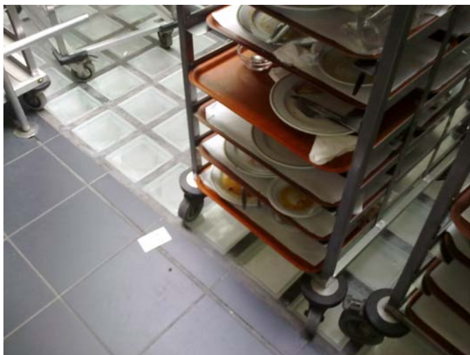
Fig.4.26. – Exposição da superfície dos blocos de vidro a gorduras de alimentos
