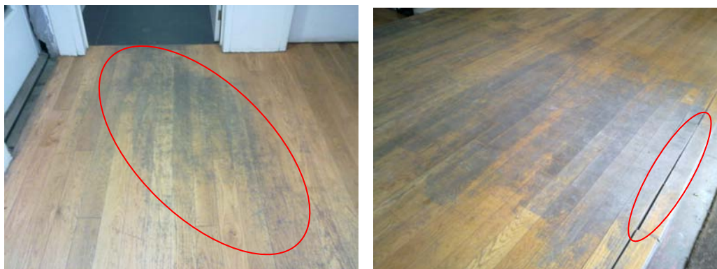
Fig.4.29. – Madeira maciça sujeita a tráfego pedestre intenso
