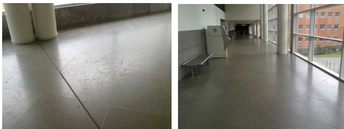
Fig.7.5. – Pedra natural no corredor do edifício B
