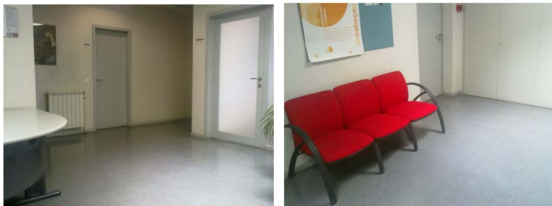
Fig.7.4. – Linóleo nas zonas de circulação e permanência no edifício A
