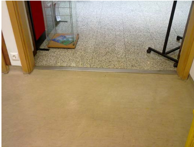
Fig.4.52. – Combinação com outro material de revestimento de piso
