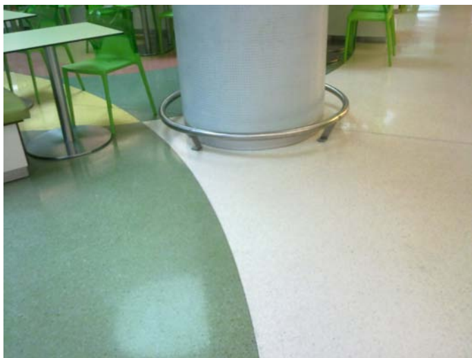
Fig.4.51. – Aplicação de revestimento em linóleo em edifício comercial
