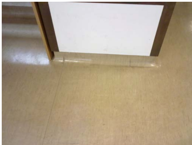
Fig.4.53. – Revestimento de linóleo com criação de rodapé e “meia cana”
