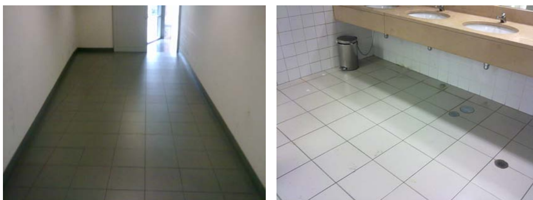
Fig.7.2. – Ladrilhos cerâmicos em corredores e instalações sanitárias do edifício A
