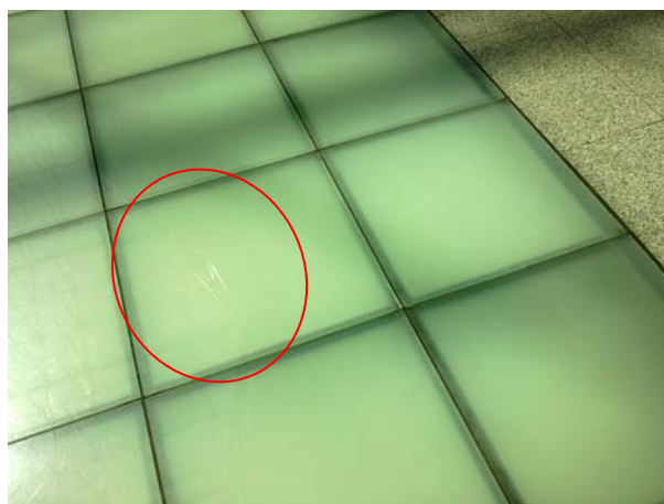
Fig.4.25. – Riscagem da superfície dos blocos de vidro para pavimento
