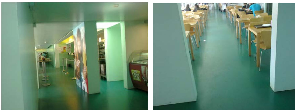
Fig.7.20. – Revestimento de resina de epóxi na cafetaria do edifício O
