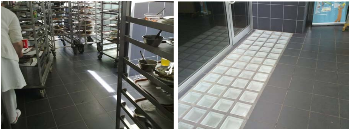
Fig.7.22. – Ladrilhos cerâmicos combinados com o vidro no edifício P
