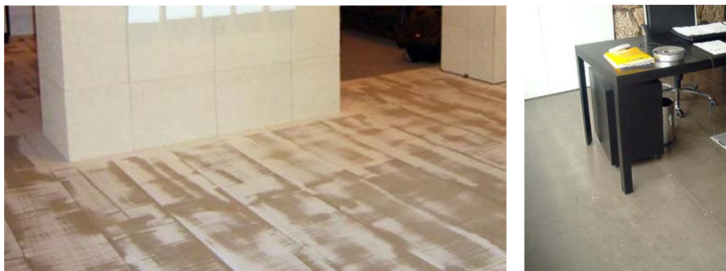
Fig.4.38. – Aplicação de painéis compósitos tipo “Viroc” [59]
