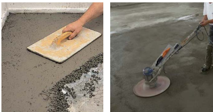
Fig.4.16. – Regularização e preparação do suporte [38]
