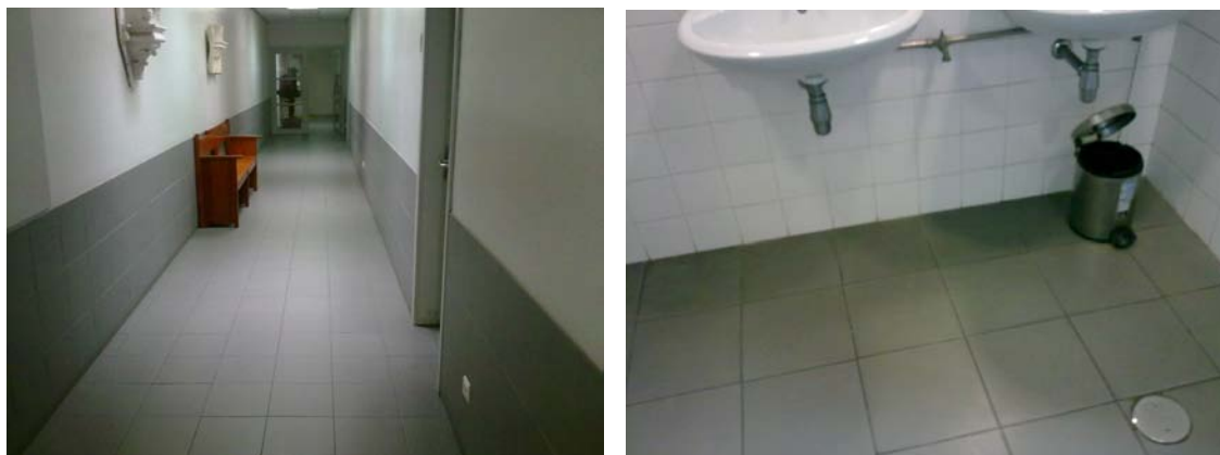
Fig.7.13. – Ladrilhos cerâmicos em zonas de circulação e de serviço do edifício G
