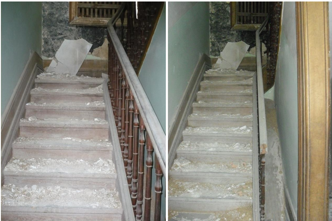
Figura 3.70 - Escadas de ligação do nível 0 ao nível 1 em 2009 e 2011
