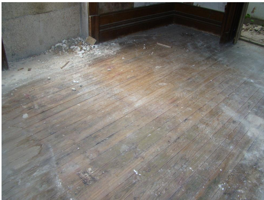
Figura 3.27 – Revestimento do pavimento em soalho
