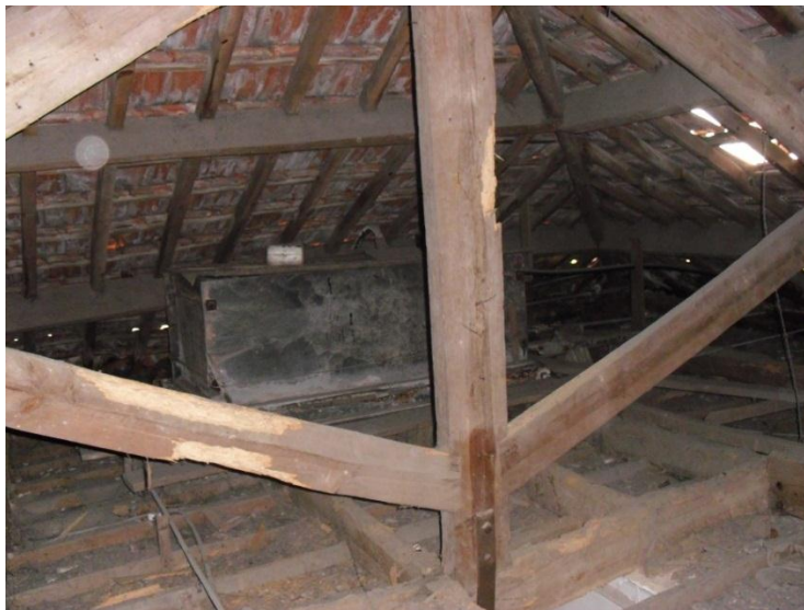
Figura 3.16 – Aspecto geral da cobertura
