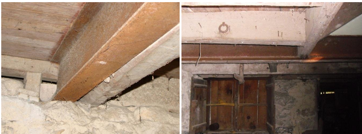
Figura 3.72 - Viga metálica do pavimento do nível 0 em 2009 e em 2011
