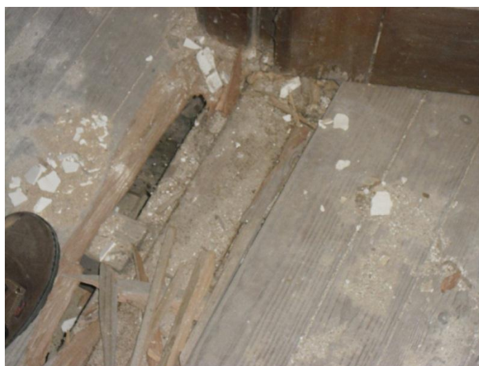
Figura 3.26 – Viga metálica do pavimento do nível 1
