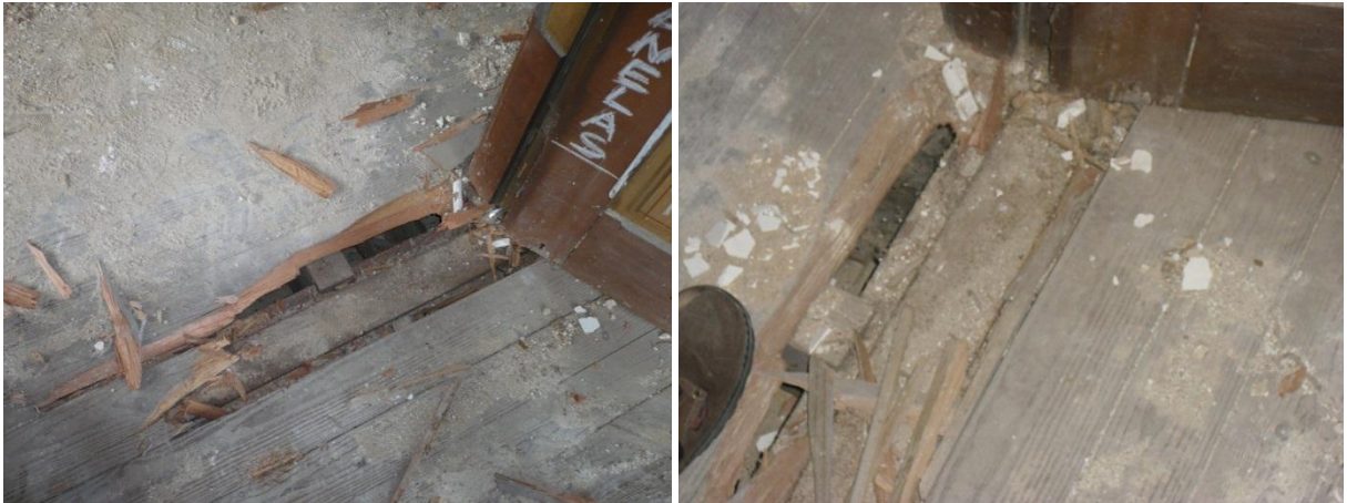
Figura 3.73 - Viga metálica do pavimento do nível 1 em 2009 e em 2011
