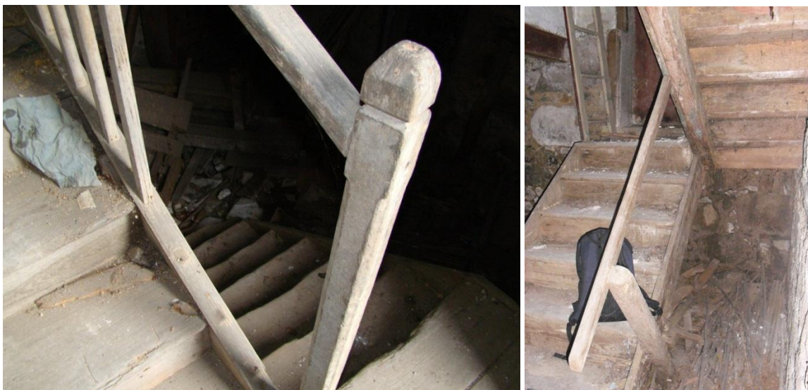
Figura 3.71 - Escadas de ligação do nível -1 ao nível 0 em 2009 e 2011
