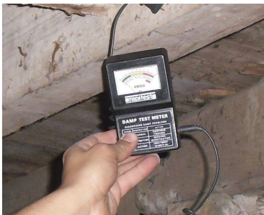
Figura 3.35 - Medição do teor em humidade numa viga do pavimento do nível 0
