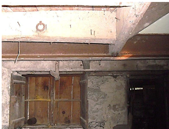
Figura 3.25 – Viga metálica do pavimento do nível 0
