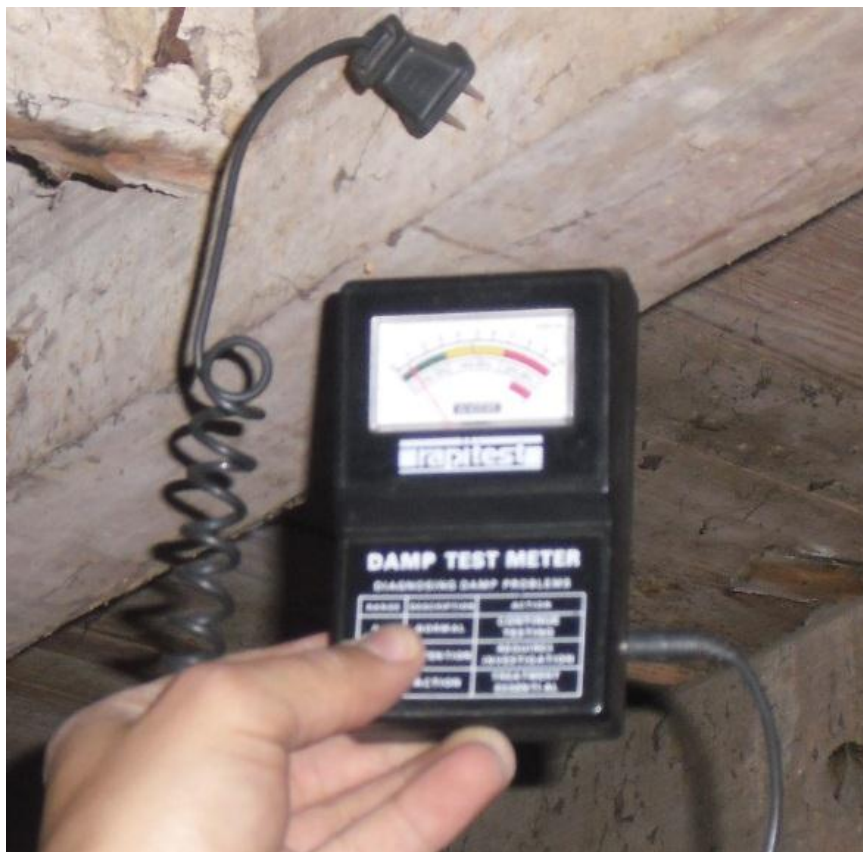
Figura 3.34 – Medição do teor em humidade numa viga do pavimento do nível 0
