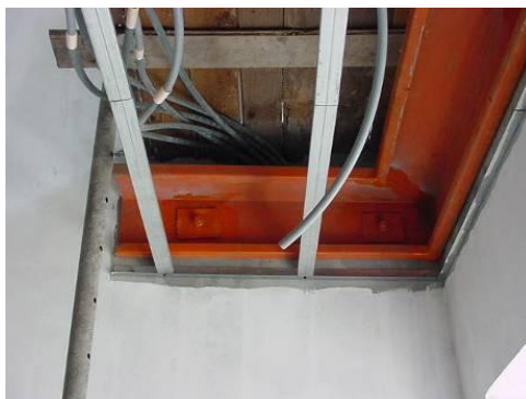
Figura 4.5 – Utilização de cantoneiras contínuas (IC)
