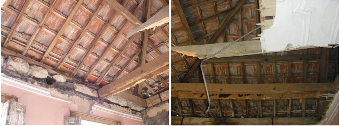
Figura 3.66 – Aspecto geral da cobertura em 2009 e 2011
