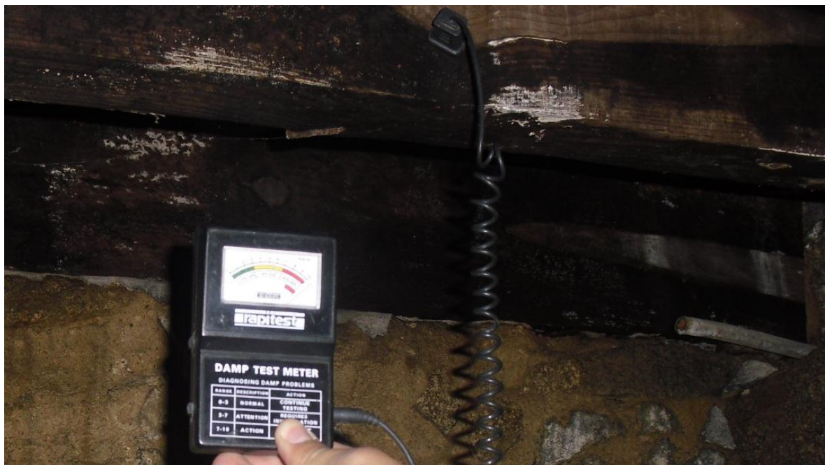
Figura 3.33 – Medição do teor em humidade numa viga do pavimento do nível 0
