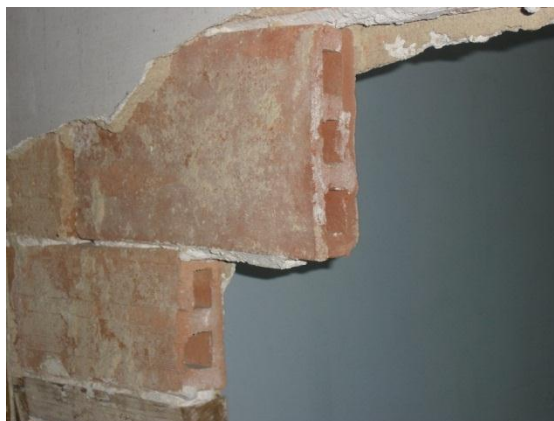
Figura 3.19 – Parede divisória de tijolo
