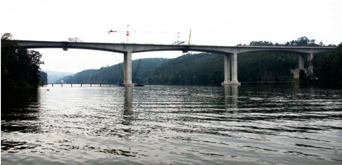
Fig. 5.5 – Ponte sobre o Rio Douro em fase de construção
