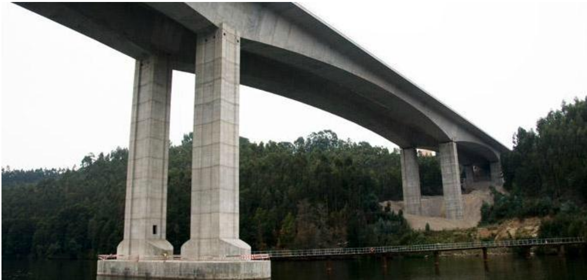
Fig. 5.10 – Pormenor de uma ligação monolítica tabuleiro-pilar.
