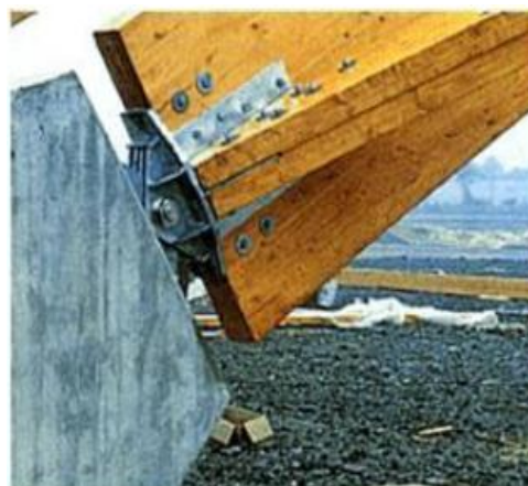
Fig. 26 – Exemplo de apoio de arco
