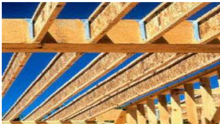
Fig. 18 – Estrutura em LVL
