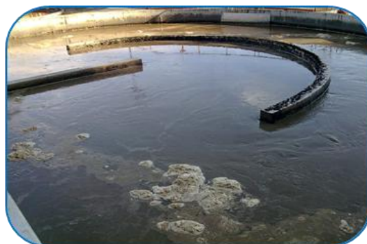
Figura 13 Zona anóxica do tanque de tratamento
