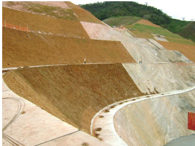
Fig. 2.1 – Medida de estabilização de um talude (Gerscovich, 2009)
