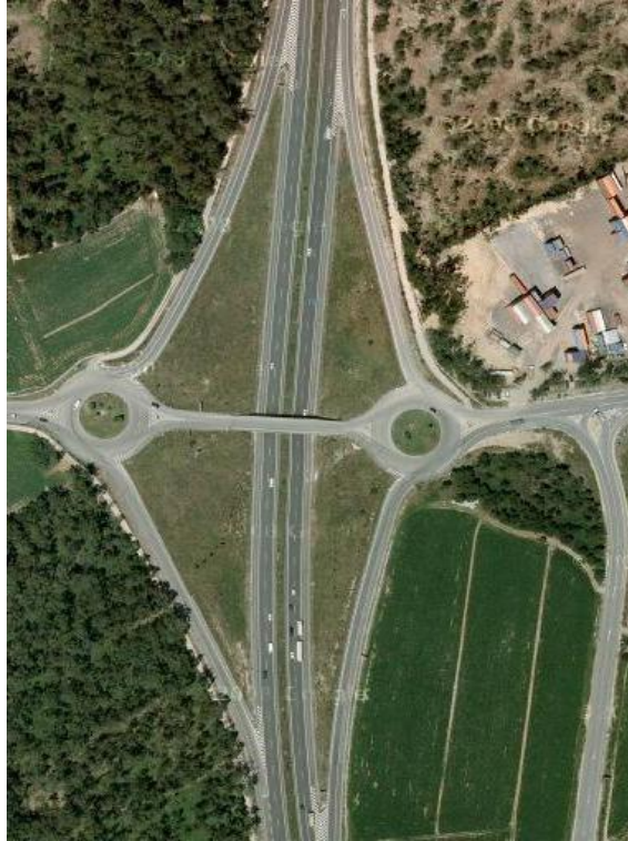
Fig.4 – Vista aérea de um nó de ligação em diamante com dupla rotunda (Fonte: Google Maps)
