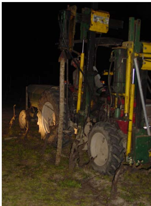
Figura 5.3 – Instalação de poste de madeira no campo
