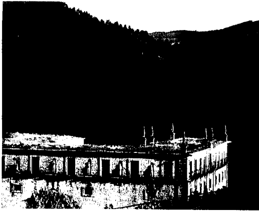
(30) A cobertura plana
