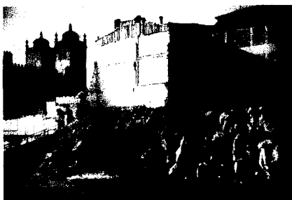
25. Zona envolvente à Sé do Porto, durante as obras de demolição realizadas pela DGEMN (anos 40).
