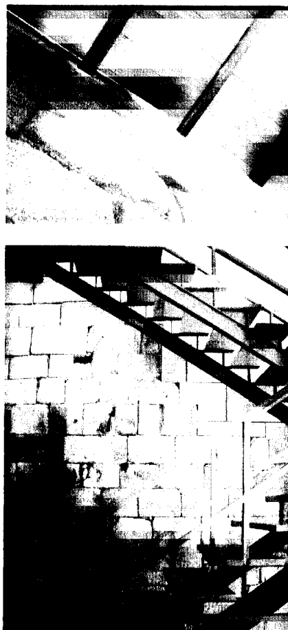
17, 18. Pormenor das lajes de piso e das escadas.
