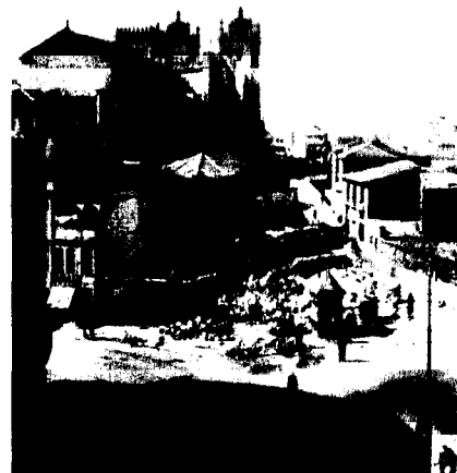
3. Zona envolvente à Sé do Porto, obras de demolição realizadas pela DGEMN (anos 40).
