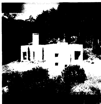
33, 34. Casa na Serra da Arrábida, Setúbal (1994-2002).
