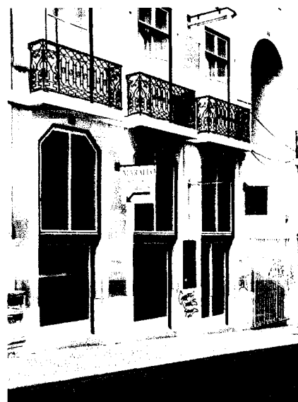
44. Vista de um dos edifícios recuperados. Rua do Carmo, Chiado.
