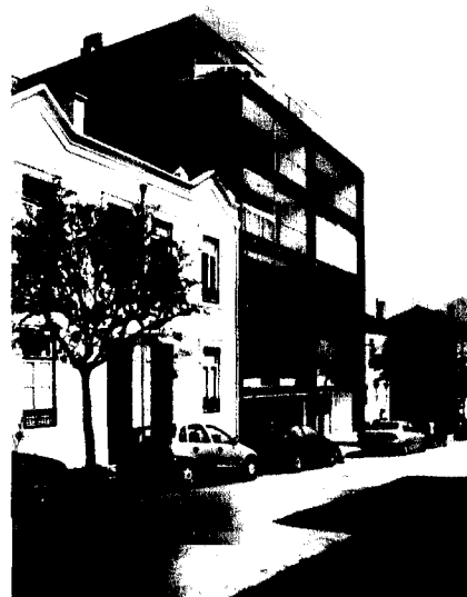
72. O edifício. Rua do Teatro, vista oeste.
