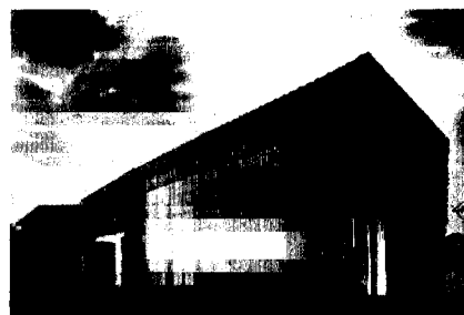
59, 60. Reconversão de Palheiro na Cortegaça, Mortágua (2000-2003).
