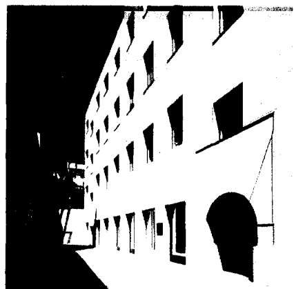
33. Reconstrução do Chiado, Lisboa, Álvaro Siza (1989-1997). Interior de um quarteirão.
