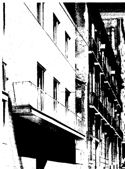
49. Fachada voltada à rua A.M. Cardoso. A relação com as construções existentes.
