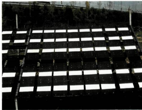
Figura 7.5 Geotêxteis expostos ao ar livre
