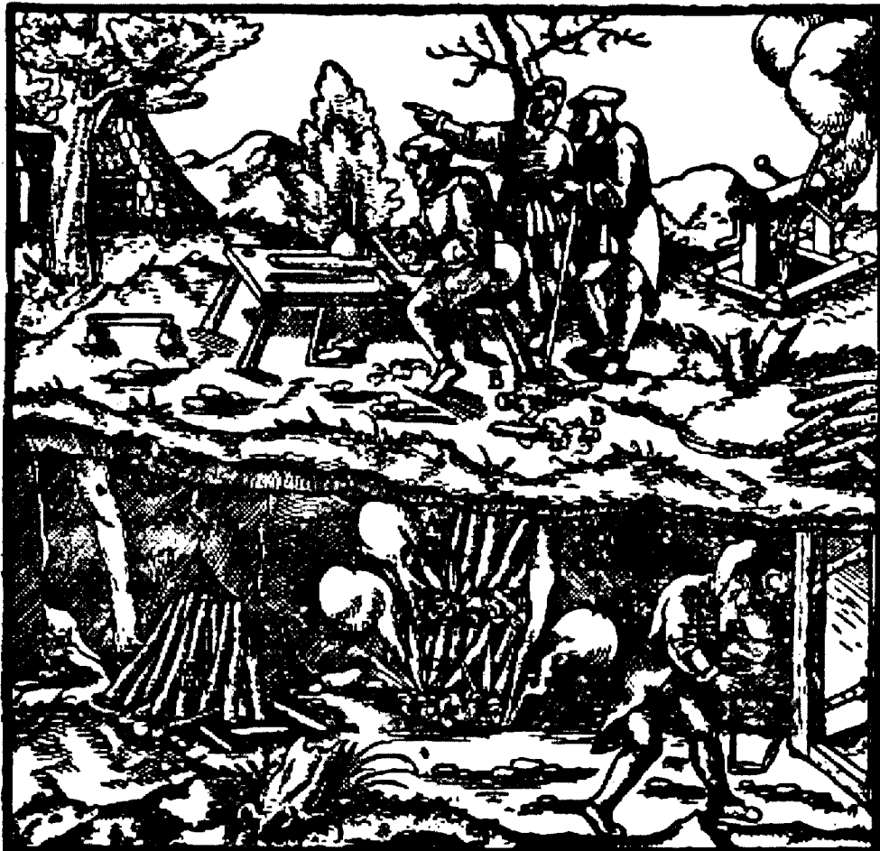
Figura 4.15. – Desmonte por utilização de fogo (AGRICOLA, 1556).
