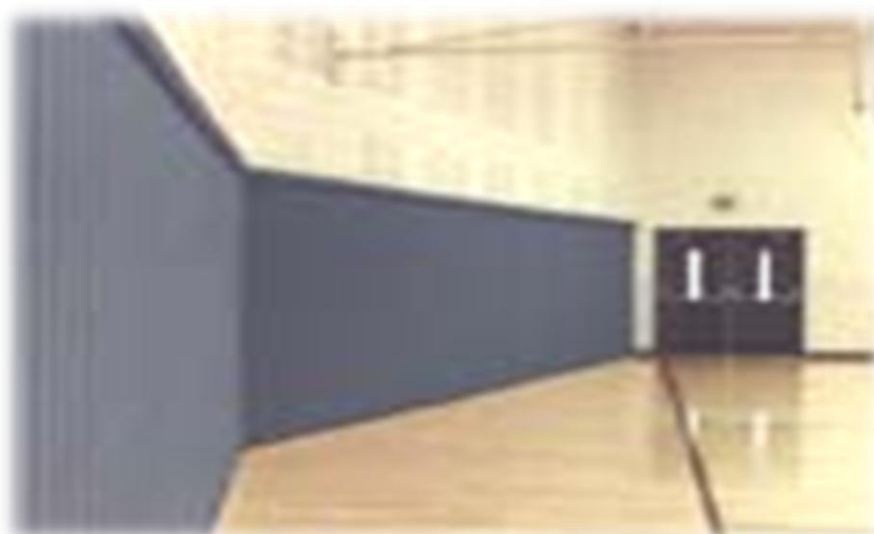
Figura 6.8 - Painéis absorventes enroláveis colocados num ginásio.
