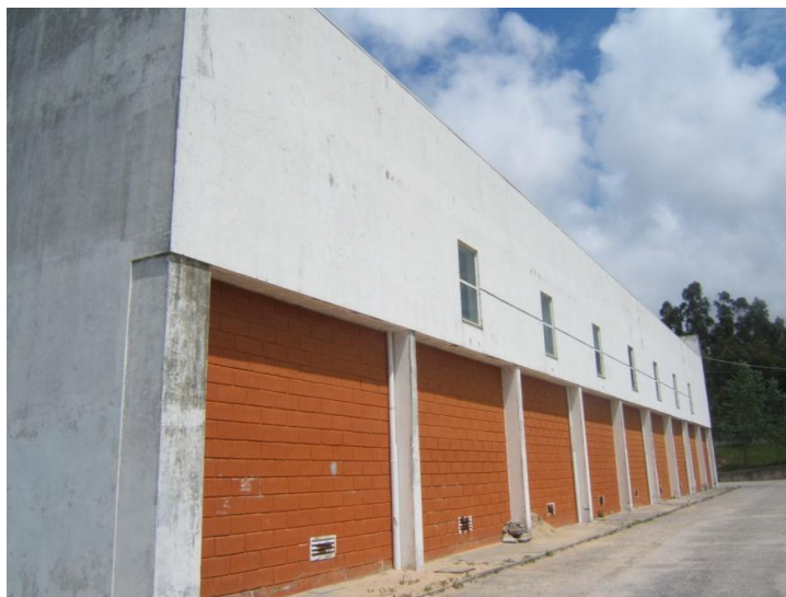
Figura 2.12 – Exterior da Escola Secundária de Esmoriz (Escola n.º 44). [Fotografia da autora]
