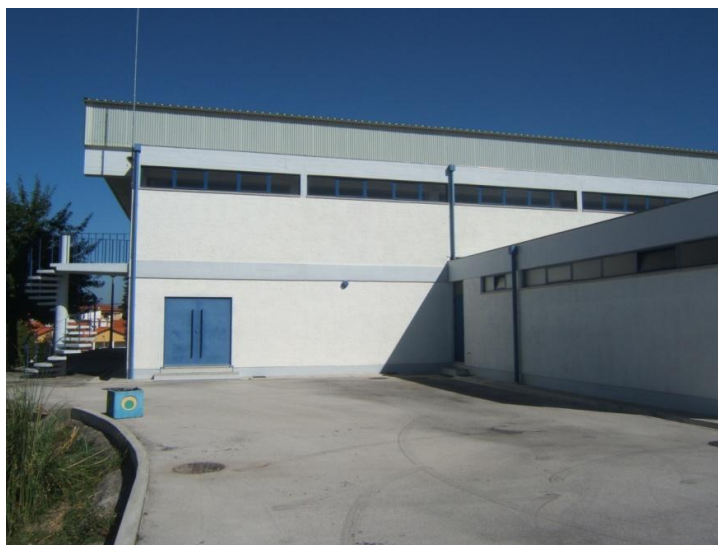
Figura 2.8 – Exterior da Escola Secundária de Albergaria-a-Velha (Escola n.º 18). [Fotografia da autora]
