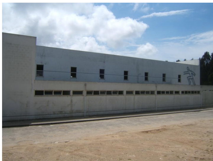
Figura 2.11 – Exterior da Escola Secundária de Esmoriz (Escola n.º 44). [Fotografia da autora]
