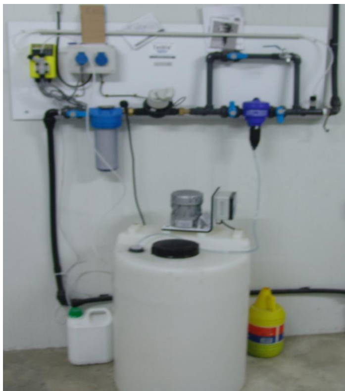
Fotografia 13: Depósito para a preparação de medicação, a administrar pela água de consumo; associado a um dosificador de Peroxido de Hidrogénio.
