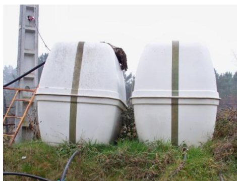
Fotografia 12: Reservatórios de água exteriores.
