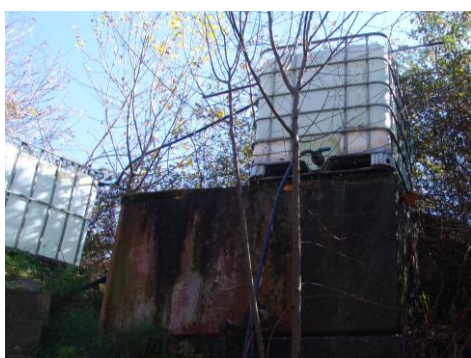
Fotografia 11: Reservatórios de água exteriores.
