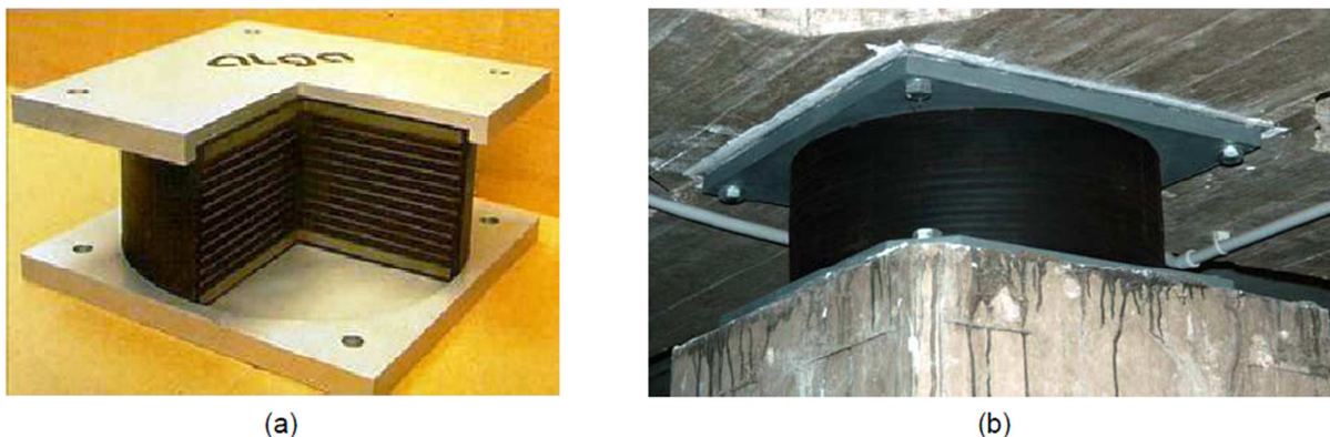
Figura 2.29 – Apoio de borracha de alto amortecimento (a) estrutura interna (b) aplicação em obra
