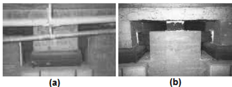
Figura 2.27 – Sistema de isolamento de base (a) bloco de borracha (b) bloco de vidro (adaptado de Guerreiro, 2003)
