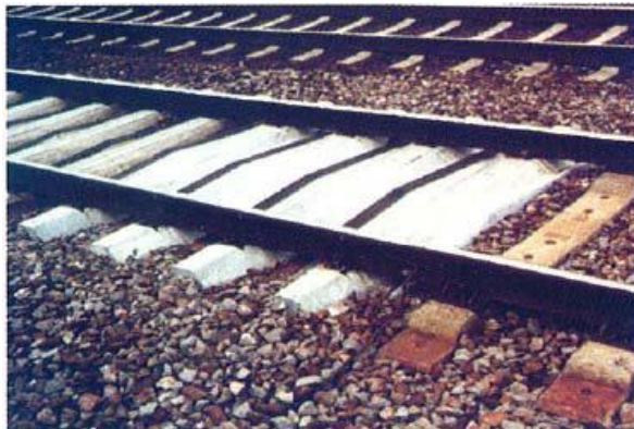
Fig. 47 – Reforço de travessas (Couto, 2008)
