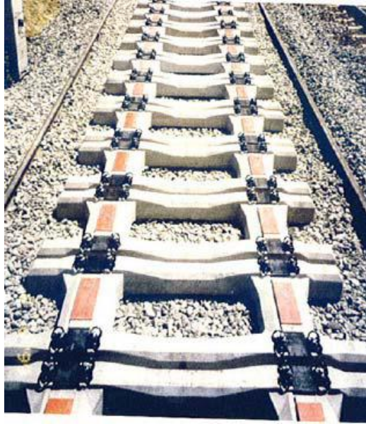
Fig. 48 – Estruturas "Frame sleeper" (Couto, 2008)
