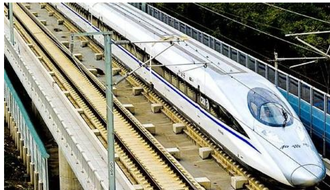
Fig. 36 – Via-férrea não balastrada da linha de alta velocidade Chinesa ( Jornal do Comércio , 2011)
