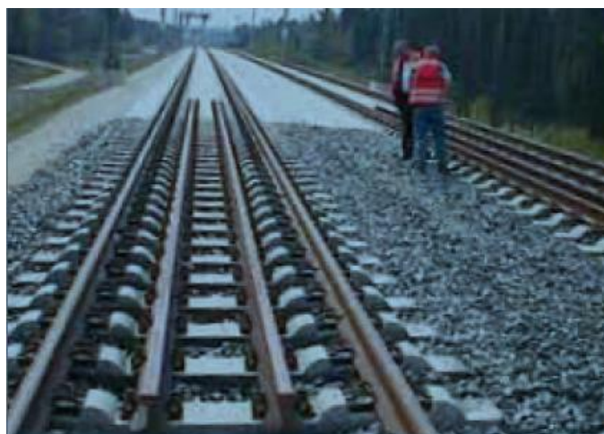
Fig. 51 – Carris extra ao longo da zona de transição (Nóbrega, 2010)
