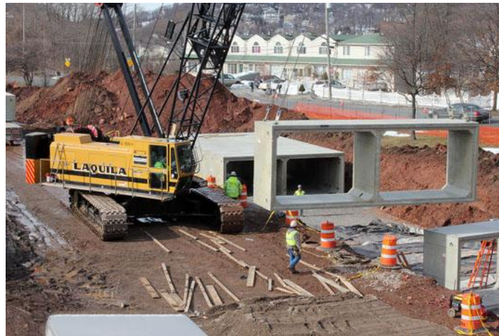
Fig. 16 – Exemplo de colocação em obra de box-culverts ( Engenhariacivil.com , 2011)
