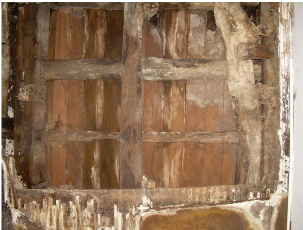
Fig.2.5 – Estrutura do telhado
