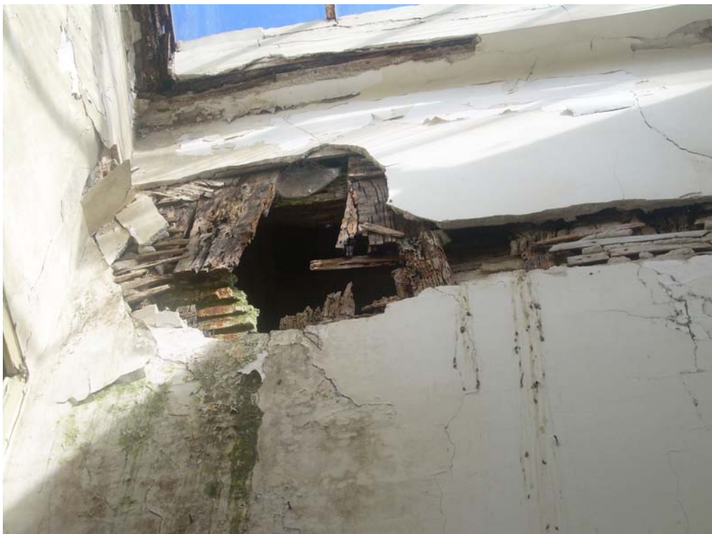
Fig.2.4 – Paredes interiores de tabique
