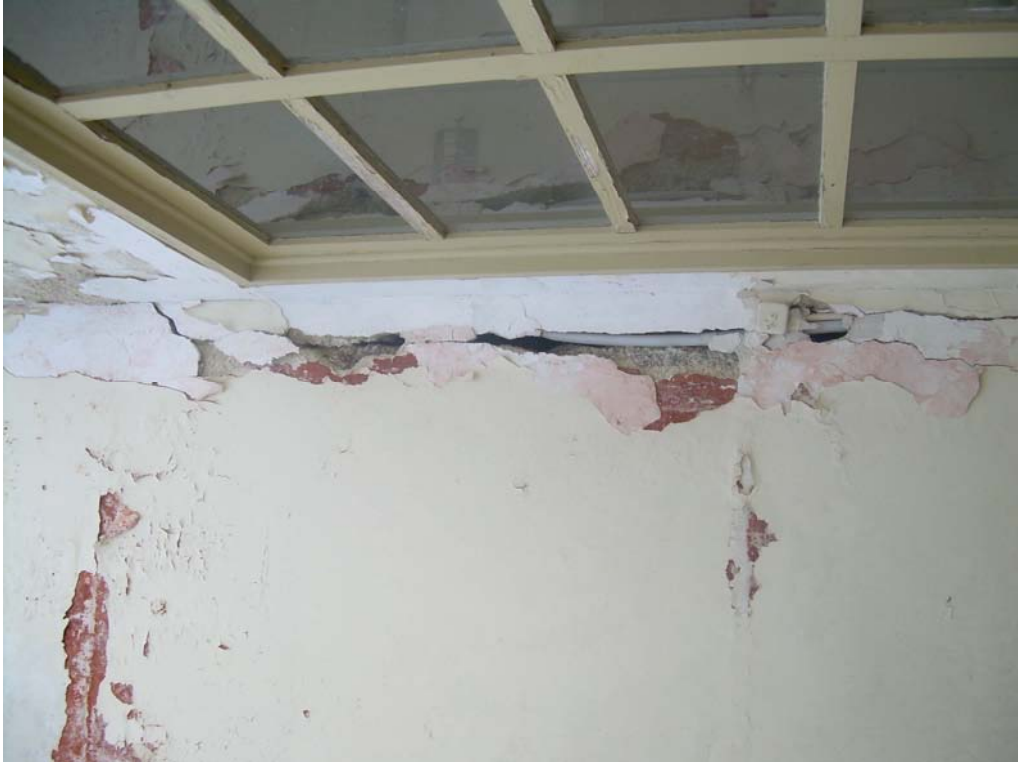
Fig.2.3 – Paredes interiores de alvenaria em tijolo cerâmico
