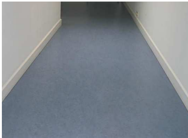
Fig. 3.21 – Exemplo de pavimento vinílico [43]
