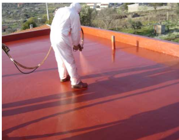
Fig. 7.1 – Exemplo de aplicação de Poliureia numa cobertura plana
