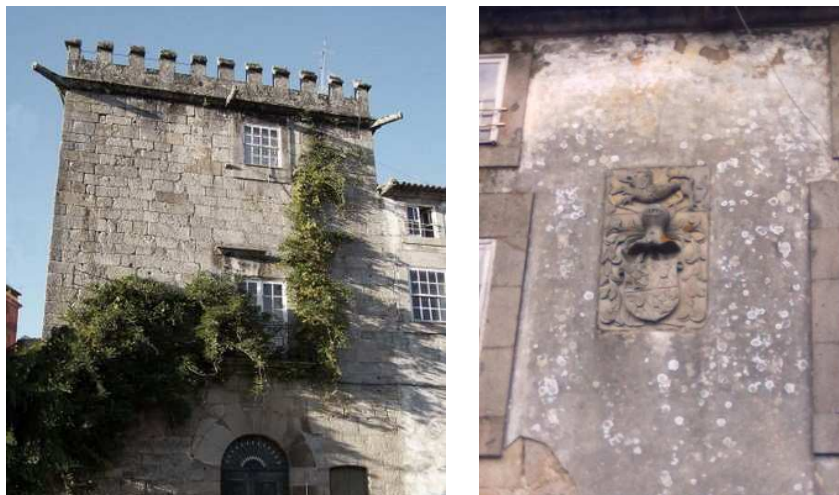
Fig. 3.14 e 3.15 – Exemplos de cantaria de granito - Torre em granito da C.B.A. e o seu brasão
