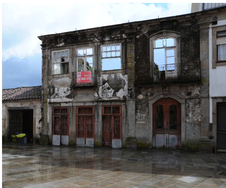
Fig.2.1 – Imóvel preexistente Hotel Largo Além Ponte – Casa n.º9
