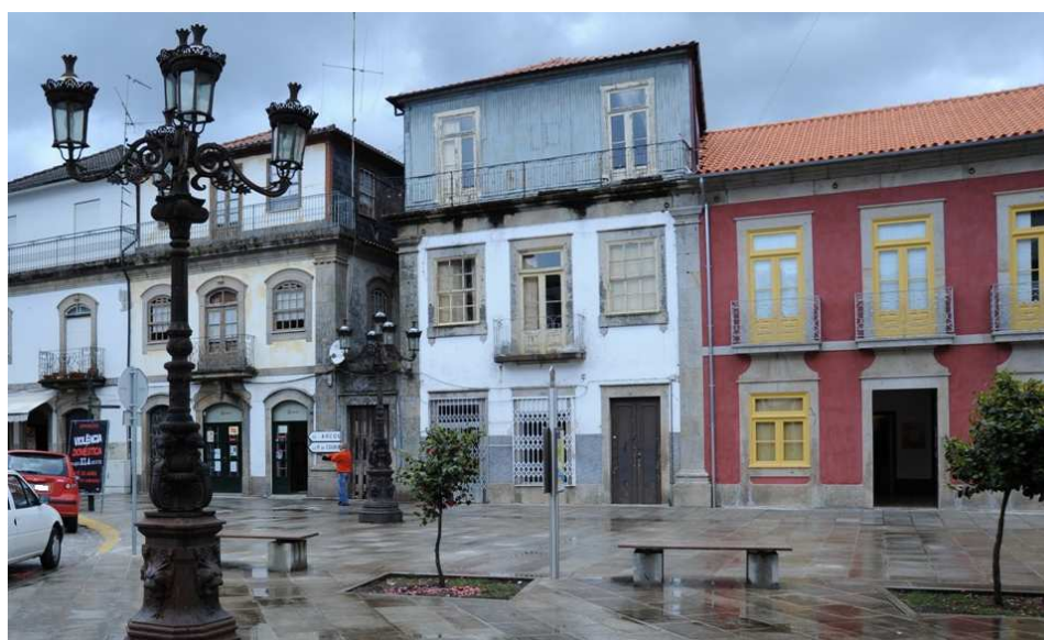
Fig. 2.10 – Imóvel preexistente Hotel Largo Além Ponte – Casa n.º24
