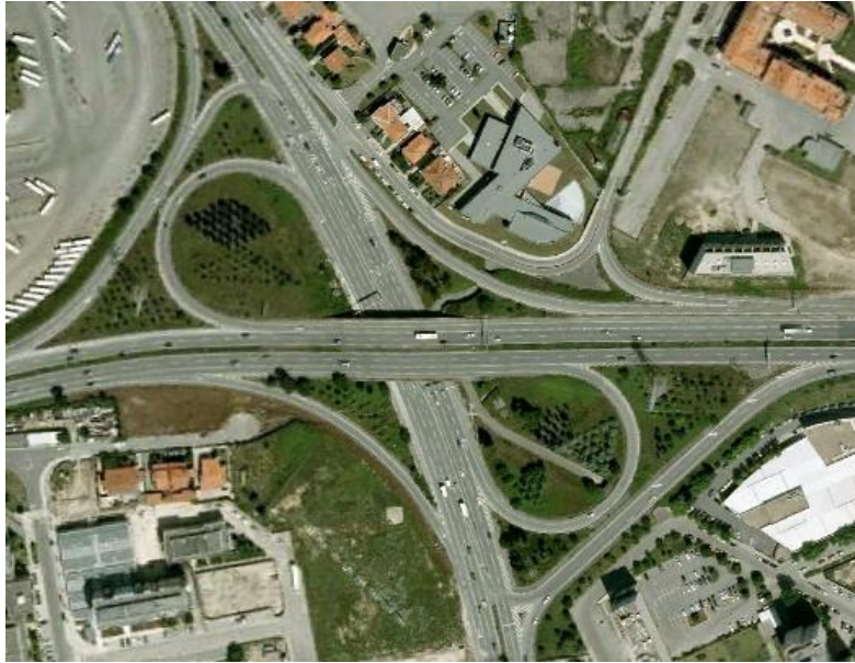
Fig. 2 – Nó em meio-trevo completo na intersecção da Estrada da Circunvalação com a Via Norte
