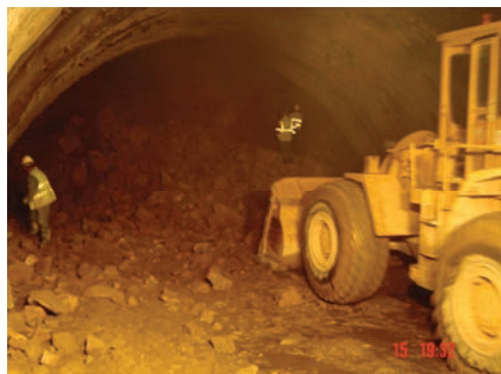
Fig. 2.8 – Equipamento de remoção (pá carregadora) (Autoestrada A27-Ponte de Lima)
