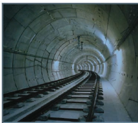
Fig. 1.4 – Túnel do sistema de Metro ligeiro da área metropolitana do Porto http://soaresdacosta.pt/documents/institucional/Media/Brochuras/Tuneis.pdf
