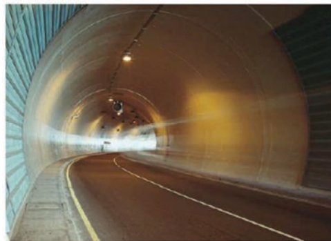
Fig. 1.3 – Túneis rodoviários do Porto, túnel 4 http://soaresdacosta.pt/documents/institucional/Media/Brochuras/Tuneis.pdf
