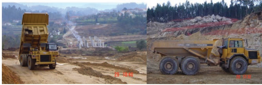
Fig. 2.9 – Equipamentos de transporte (Dumper e Camião articulado) (Autoestrada A27-Ponte de Lima)
