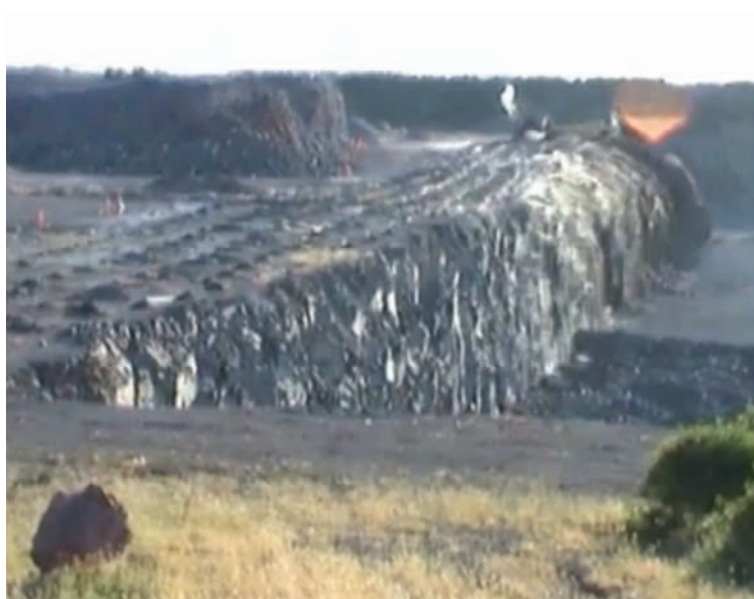
Fig. 3.1- Detonação de uma pega de fogo em bancada http://www.youtube.com/watch?v=UINVb8zILrI
