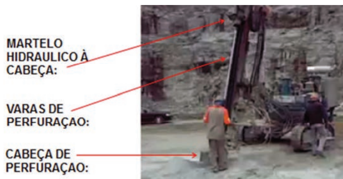
Fig. 5.6 – O equipamento de perfuração executando perfuração em bancada e constituição dos acessórios de perfuração
