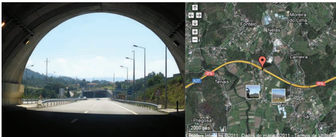
Fig. 1.5 – Túnel rodoviário da autoestrada A-27 (Portela-Ponte de Lima) http://www.panoramio.com/photo/49538785
