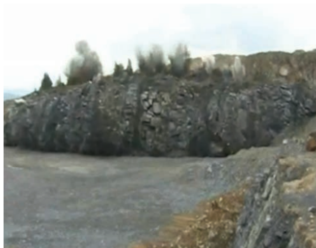
Fig. 5.3 – Pega de fogo em bancada http://www.youtube.com/watch?v=fEcva5GWglA
