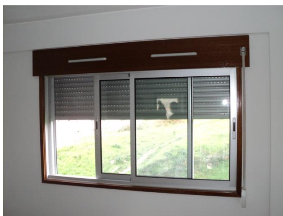
Figura 10 – Grelhas autorreguláveis existentes na Sala.
