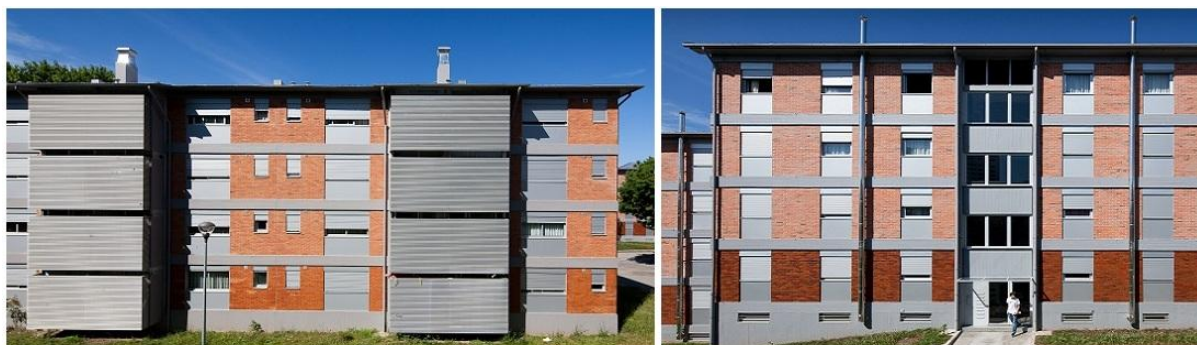
Figura 6 - Situação após reabilitação [33].
