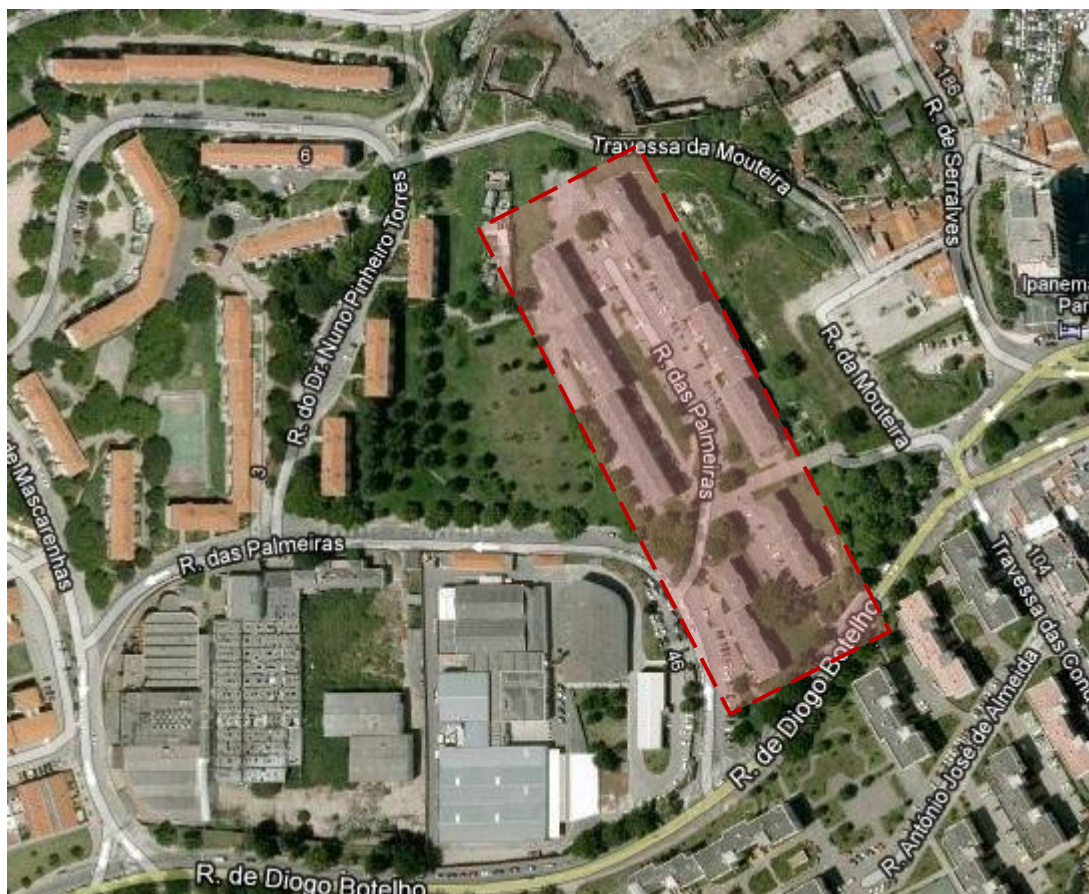
Figura 4 – Vista aérea do bairro social de Lordelo.
