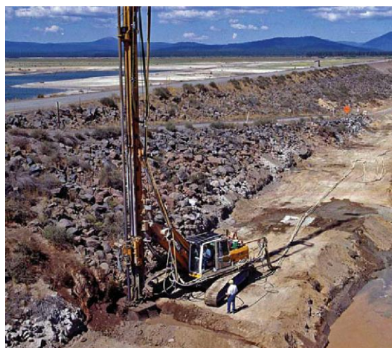
Fig. 3.17 - Máquina de perfuração e injeção (Hayward Baker, 2004)
