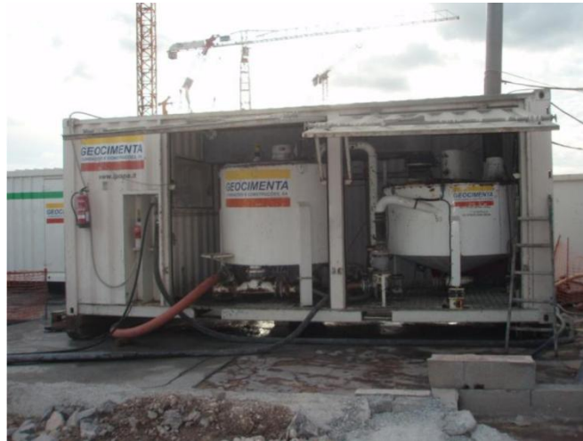
Fig. 3.16 - Central misturadora e bomba de argamassa (Ribeiro, 2010)
