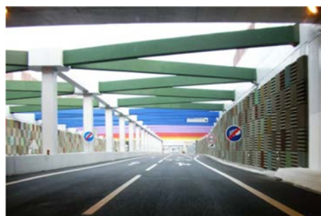
Fig. 2.23: A44 em Mafamude, Vila Nova de Gaia, onde se destacam os materiais absorventes aplicados nas paredes da via [19].
