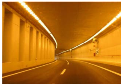
Fig. 2.21: Túnel Soares dos Reis em Mafamude, Vila Nova de Gaia [19].
