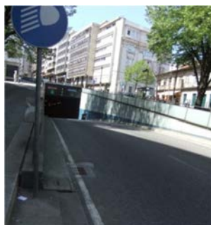
Fig. 5.57: Entrada do Túnel de Ceuta, ou Túnel dos Almadas [fotografia do autor, 5/4/2011].
