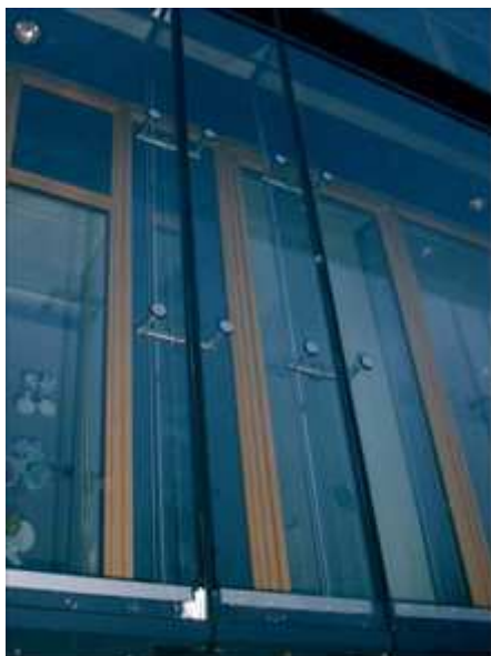
Fig. 2.18 – Revestimento de fachada ventilada em vidro, [20].
