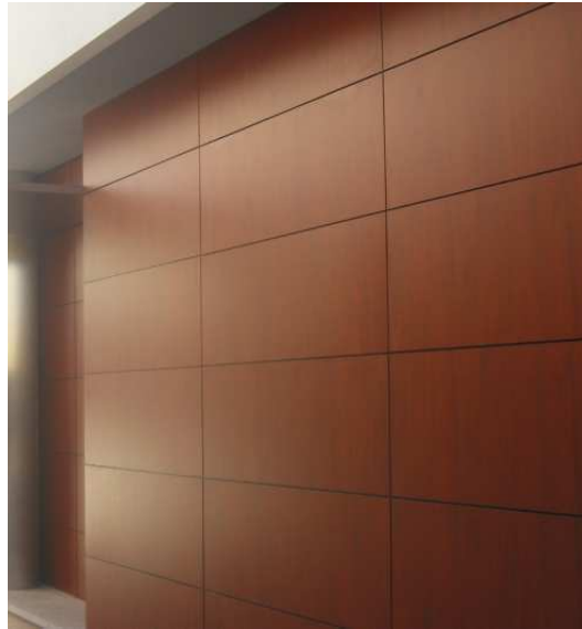
Fig. 2.16 – Revestimento em painéis fenólicos, [18].
