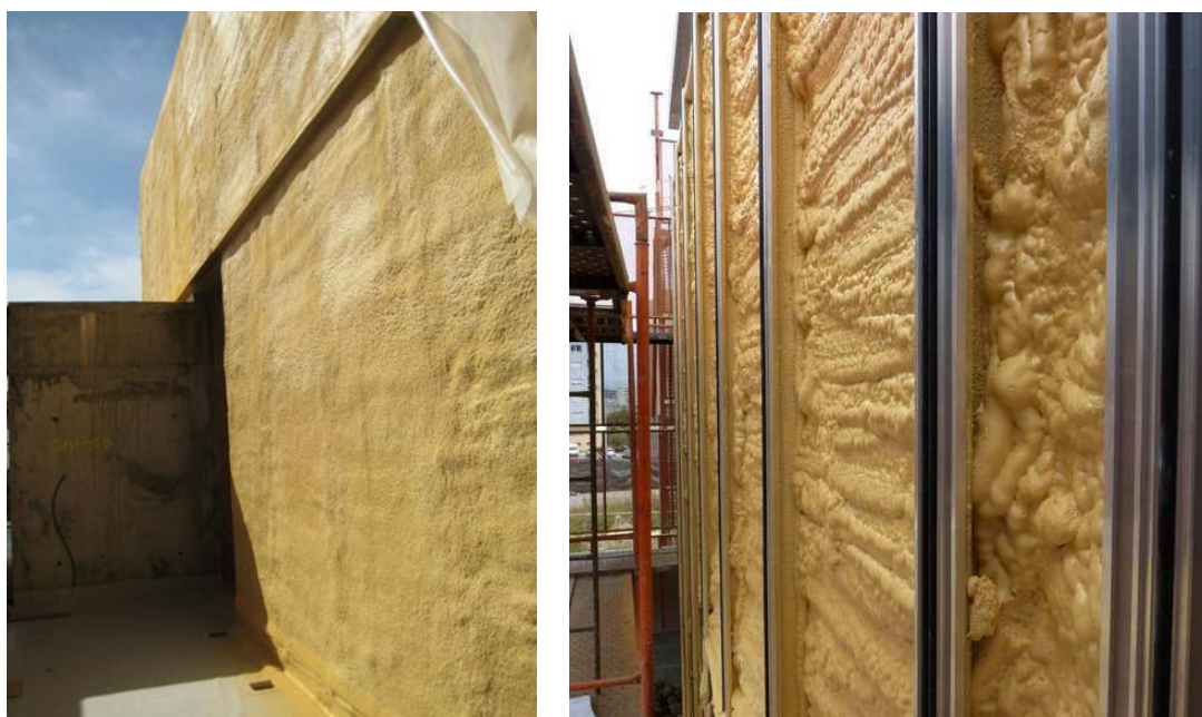
Fig. 2.20 – Isolamento térmico em poliuretano projectado aplicado em fachada.
