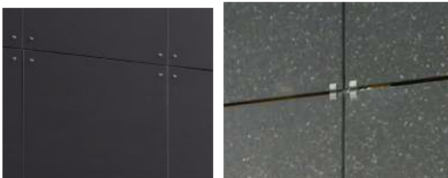
Fig. 2.9 – Fixação visível.
