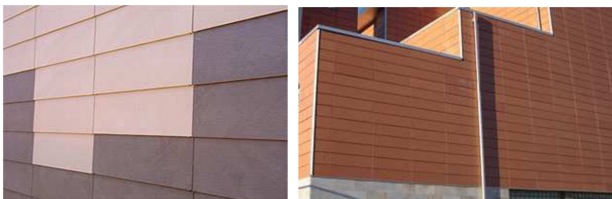
Fig. 2.12 – Revestimento em placas de grés porcelânico [15].
