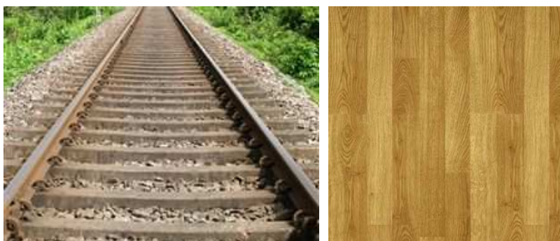
Fig. 2.13 - Aplicações da madeira de Carvalho português. Esquerda: travessas de caminhos-de-ferro (fonte: http://oje.pt ); Direita: soalho (fonte: http://flooring-manufacturers.com ).
