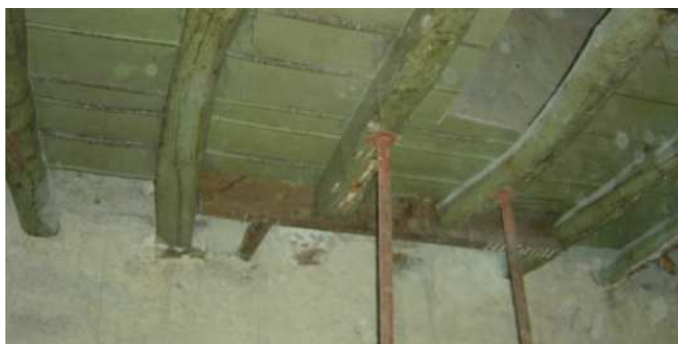
Fig. 4.1 – Forma irregular das vigas de madeira in situ (Franco, 2008).
