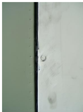
Figura 40 – Marca de cravo antes da pintura da traseira
