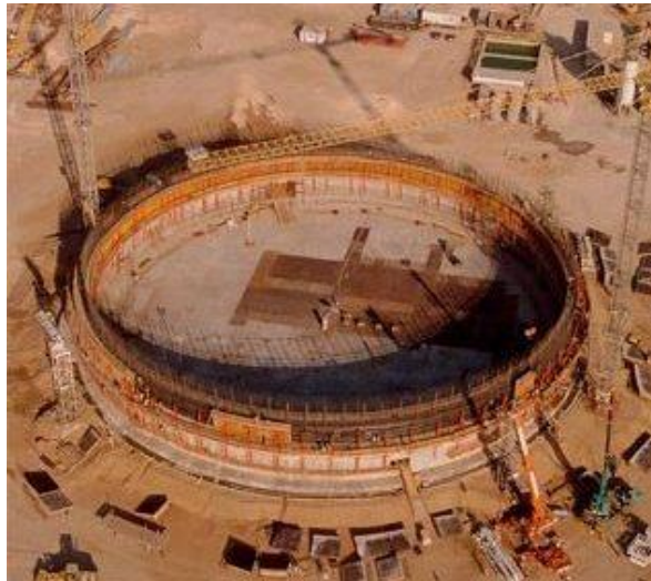
Fig. 1.10 – Forma Trepante.
