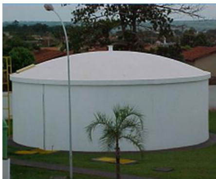
Fig. 1.4 – Reservatório Apoiado.
