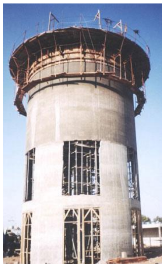
Fig. 1.11 – Forma Deslizante.
