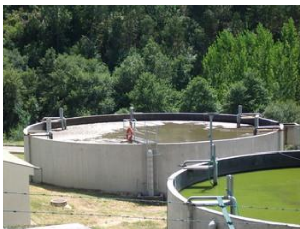
Fig. 1.3 – Reservatório Semi-Enterrado, Etar de Miranda do Corvo.
