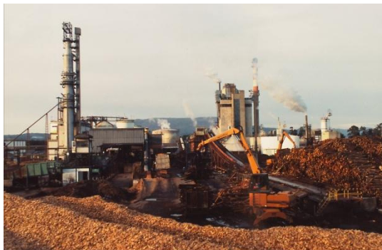
Figura 9 - Vista parcial do parque e dos destroçadores de madeira.
