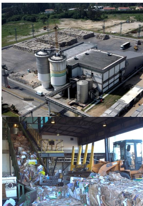
Figura 14 - Instalação de fibra secundária.
