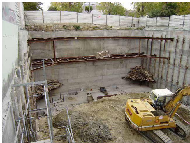
Fig. 2.21 – Vista dos trabalhos relativos à fase final da escavação (JetS, 2010)
