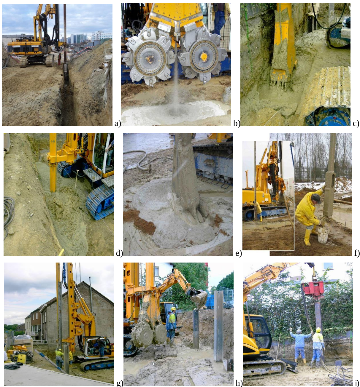
Fig. 2.32 – Ilustração do processo de execução da técnica Cutter Soil Mixing (Peixoto 2011)
