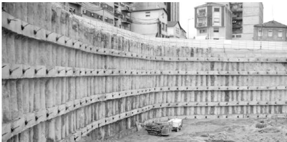
Fig. 2.18 – Estrutura de contenção do centro comercial “El Corte Inglés” em fase de construção (Antunes et al. [s.d.])
