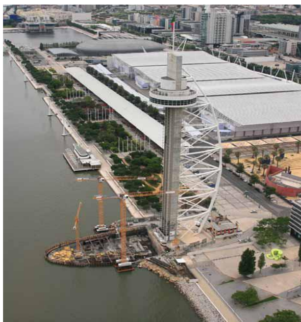
Fig. 2.19 – Vista dos trabalhos de escavação abaixo da cota da água no rio Tejo (JetSJ, 2010)
