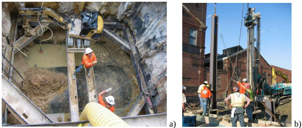
Fig. 2.14 – Estrutura de contenção: a) interior da escavação e condições de trabalho b) colocação dos perfis metálicos (Klein et al., [s. d.])
