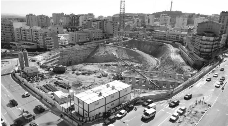
Fig. 2.16 – Vista geral da obra e da sua periferia (Antunes et al. [s.d.])
